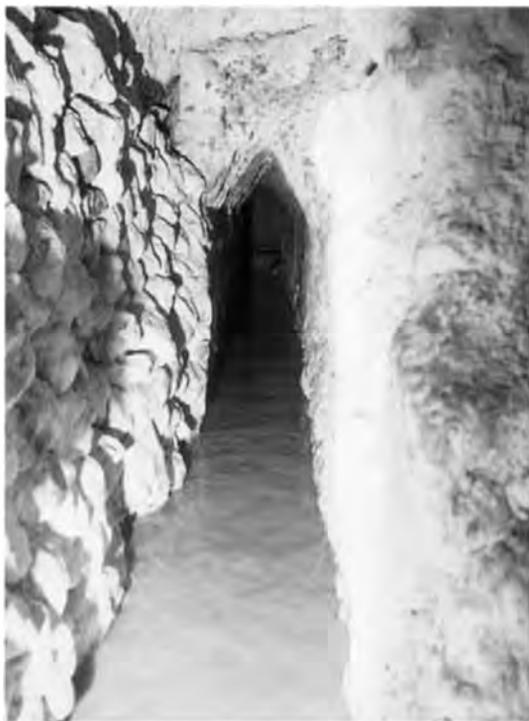
Foto 7: Il cunicolo A con la foderatura in pietre di provenienza fluviale (foto E. Burri).
