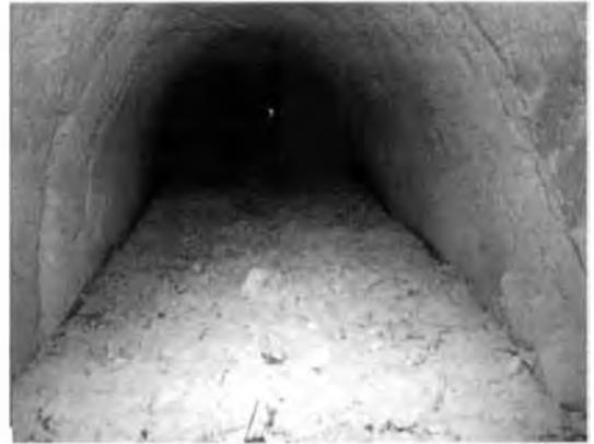
Foto 4: Ipogeo del Fico - in primo piano il materiale argilloso che ha invaso la cavità (foto degli Autori).
