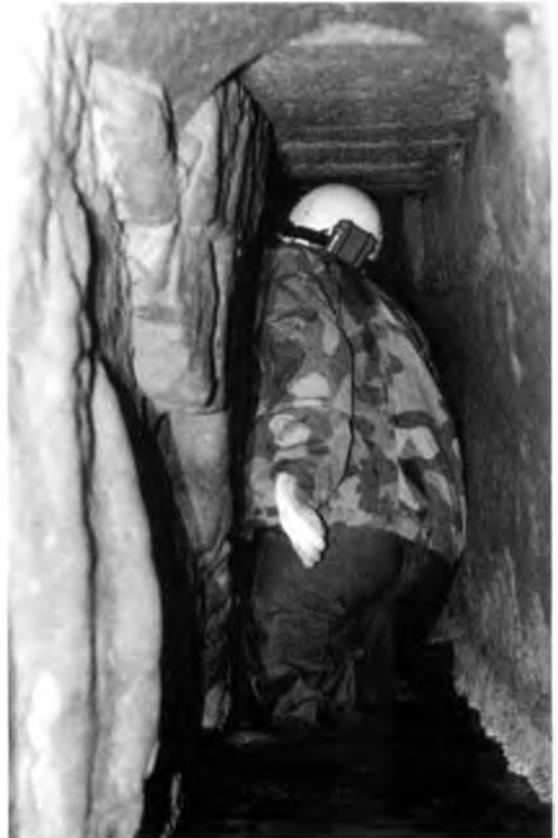
Foto 4 - Nei tratti artificiali la pressione del terreno ha talora deformato le pareti sino a rendere difficoltoso il passaggio (foto V. Castellani).
