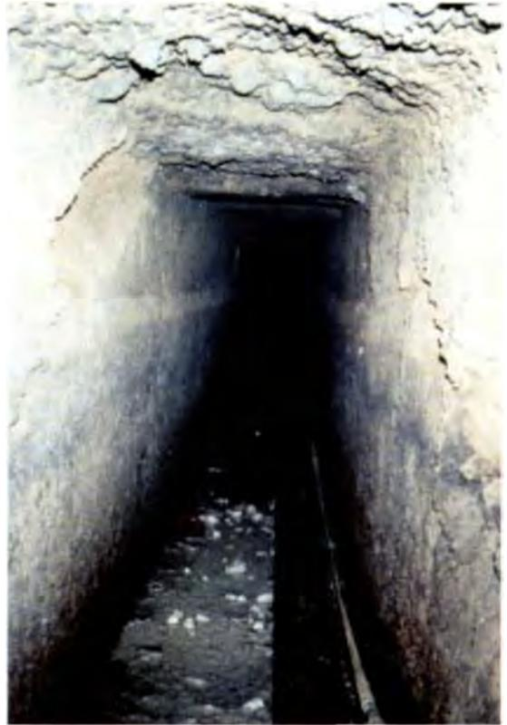
Foto 1 (a destra) - A valle del secondo by-pass, al passaggio tra i tufi e le rocce basaltiche il condotto assume una forma rigidamente rettangolare (foto V. Castellani).
