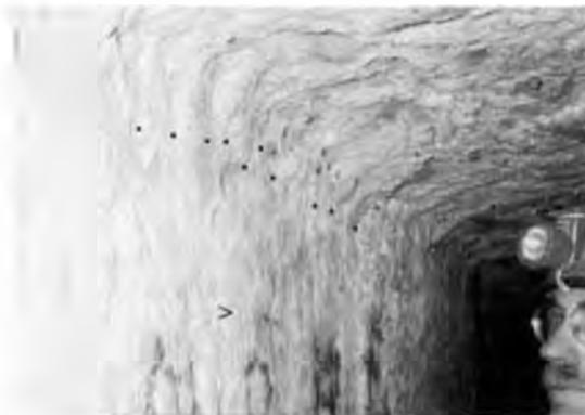
Foto 6 - Segni a parete e segni di volta in un tratto del condotto di Palestrina. Sulla parete, all'altezza degli occhi dell'osservatore una delle tipiche incisioni (frecce) da noi tentativamente identificate come segni di livello. All'incontro tra parete e volta tutta una serie di segni di volta (punti all'estremità inferiore del segno) la cui corrispondenza con le cornici di scavo lascia pochi dubbi sulla funzione di marcatura dei turni di lavoro (foto V. Castellani).
