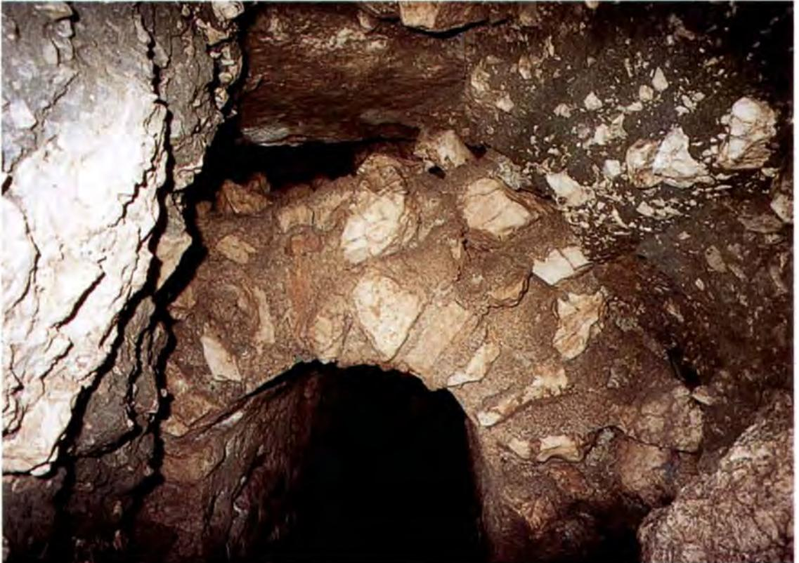
corribili presentano sezione tondeggiante di circa 1,2 m di diametro; il pavimento è occupato da uno spesso strato di fango liquido molto vischioso. Il condotto termina contro una frana che sembra provenire dall'interno (crollo? *puteus* occluso?), ricoperta da abbondanti colate concrezionali che dimostrano come l'occlusione non sia recente; dal soffitto pendono numerose stalattiti tubulari lunghe qualche centimetro.
