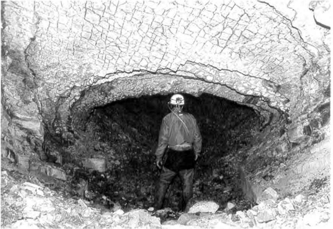
Foto 4 - Un tratto non blindato della galleria principale. I lavori di scavo del forte hanno messo in piena evidenza le stratificazioni del flysh, creando un ambiente di particolare suggestione (Foto Marco Meneghini - C.R.C. "Seppenhöfer" Gorizia)
