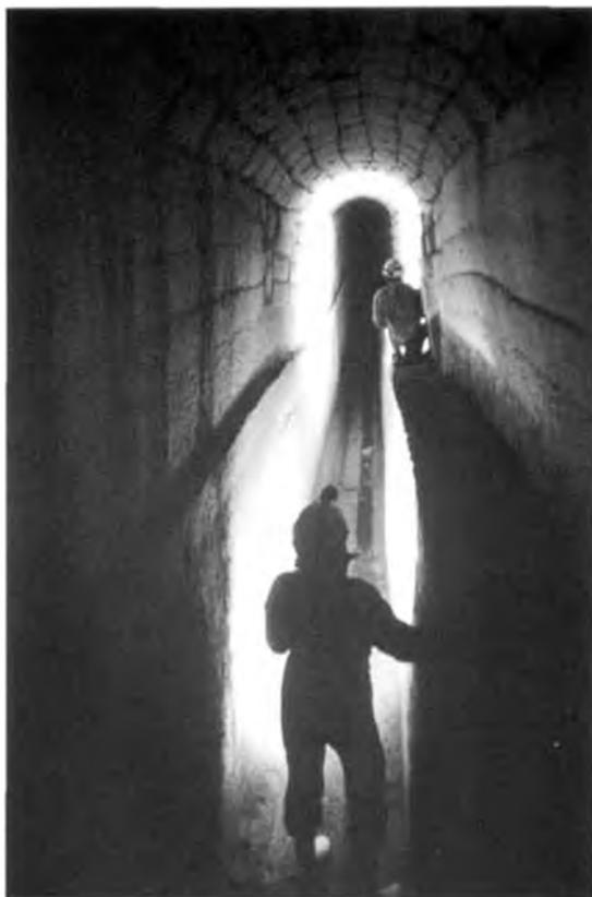
Foto 2 - Gravina di Puglia: tratto spettacolare dell'acquedotto sotterraneo. Il condotto è qui costituito da due livelli sovrapposti, scavati nella roccia viva, mentre la volta a botte è costruita in blocchi squadrati (Grafica R. Bixio)
