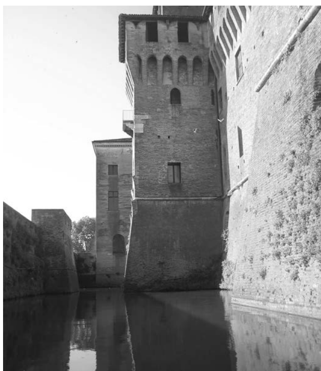
Fig. 15 - Veduta del fossato del Castello di San Giorgio (foto Bettoni P.).
