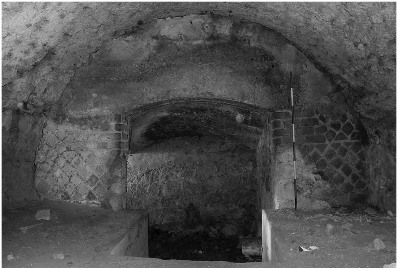
Fig. 18 - Interno del bunker *Camera Ipogea*, lato NE: visibili i paramenti murari in opera reticolata e opera vittata ancora conservati sotto l'imposta del voltino in calcestruzzo moderno (foto N. Damiano).
