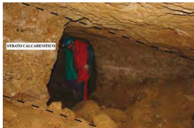
Fig. 4 - Strato calcarenitico ricco di frammenti di natura fossilifera in cui sono state scavate le gallerie (foto Enrico Maria Sacchi).
