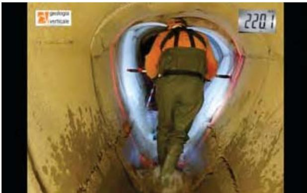
Fig. 6 - Esempio di immagine estrapolata da video con l'evidenza della progressiva metrica in condotta di piccole dimensioni.
