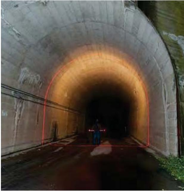
Fig. 4 - Esempio di ripresa in gallerie di media dimensione. I marker luminosi sono alla distanza di 1 m in tutte le immagini.
