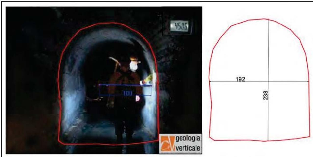
Fig. 7 - Esempio di immagine estrapolata da video con evidenza della progressiva metrica, e riporto grafico con scalatura e quotatura della sezione.
