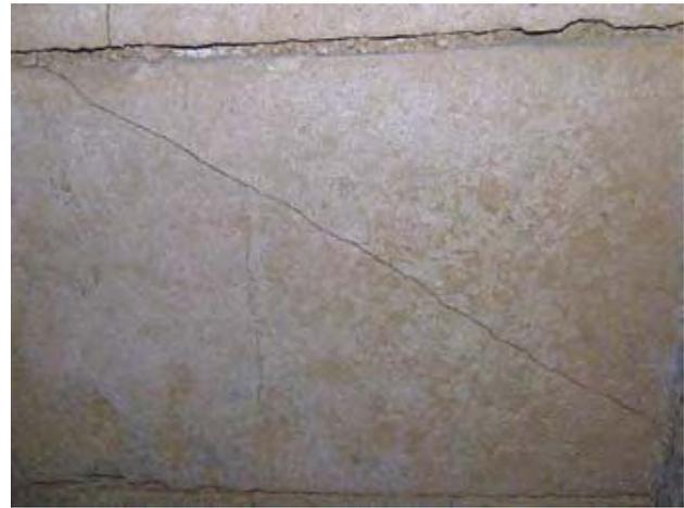
Fig. 20 - Dettaglio delle lesioni nel soffitto del dromos indicato nel rilievo topografico con il n. 5 (foto R. Varriale).
