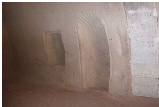
Fig. 2 - Interno e mihrab (foto F. Dell'Aquila).
