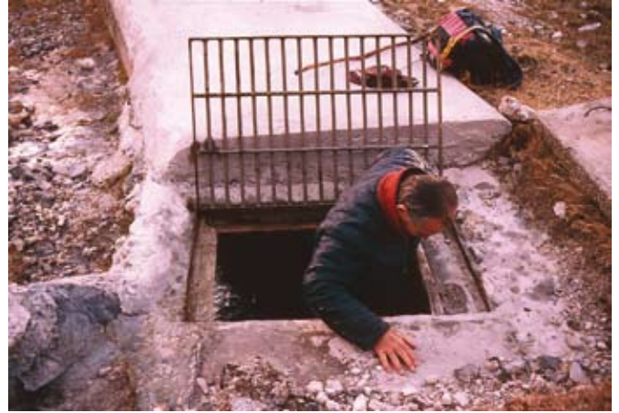
Fig. 9 - L'uscita dal traforo in Val Clarea attraverso una grata. Fig. 9 - You exit the tunnel in Val Clarea through a grate.
