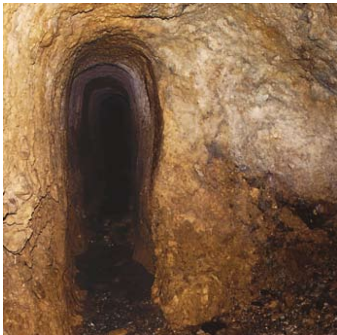
Fig. 5 - Il traforo ha una sezione media di 2 metri in altezza ed 1 in larghezza.
