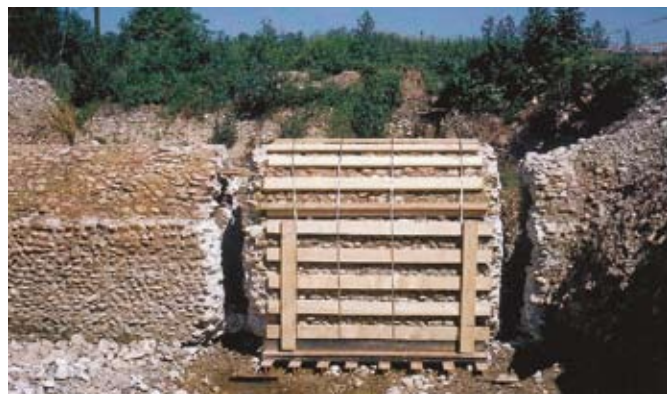
Fig. 9 - Il momento in cui il troncone dell'acquedotto è stato imbrigliato su una pedana metallica e poi asportato dal sito senza alcun danno (località Pedaggera, 1990; foto P. Barale).
