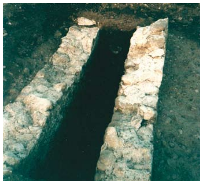
Fig. 17 - Un tratto dell'acquedotto secondario dove sono ben visibile i piedritti. Oltre questo troncone, che volge verso la cosiddetta “Cascina Castellasso”, la condotta riprende il medesimo percorso, ma ad una profondità maggiore (località Reviglio, 2006; foto P. Barale).
