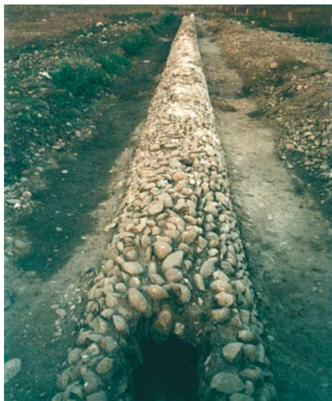
Fig. 15 - Un tratto dell'estradosso dell'acquedotto secondario visto in direzione Est (località Reviglio, 2006; foto P. Barale).
