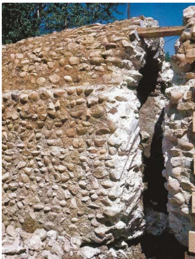
Fig. 8 - Per il necessario passaggio di un canale di scarico, l'acquedotto sotterraneo venne troncato (località Pedaggera, 1990; foto P. Barale).
