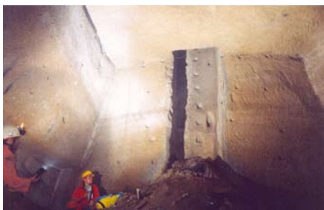
Fig. 20 - Ambito C del rilievo topografico. Dettaglio della cisterna indicata con il n. 18 (foto R. Varriale).
