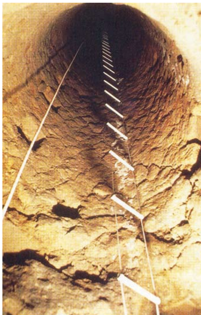
Fig. 5 - Cavità sotterranea di via S. Biagio dei Librai a Napoli. Dettaglio del pozzo in opera reticolata (da AA.VV., 1990).
