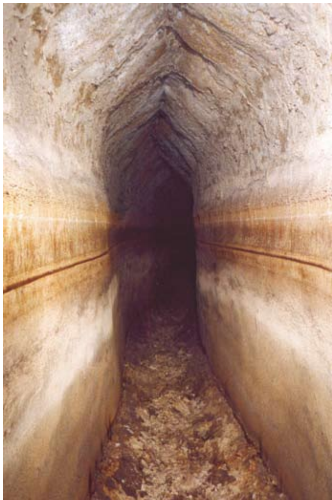
Fig. 13 - Ambito B del rilievo topografico. Dettaglio del cunicolo con copertura del soffitto a cappuccina (foto R. Varriale).
