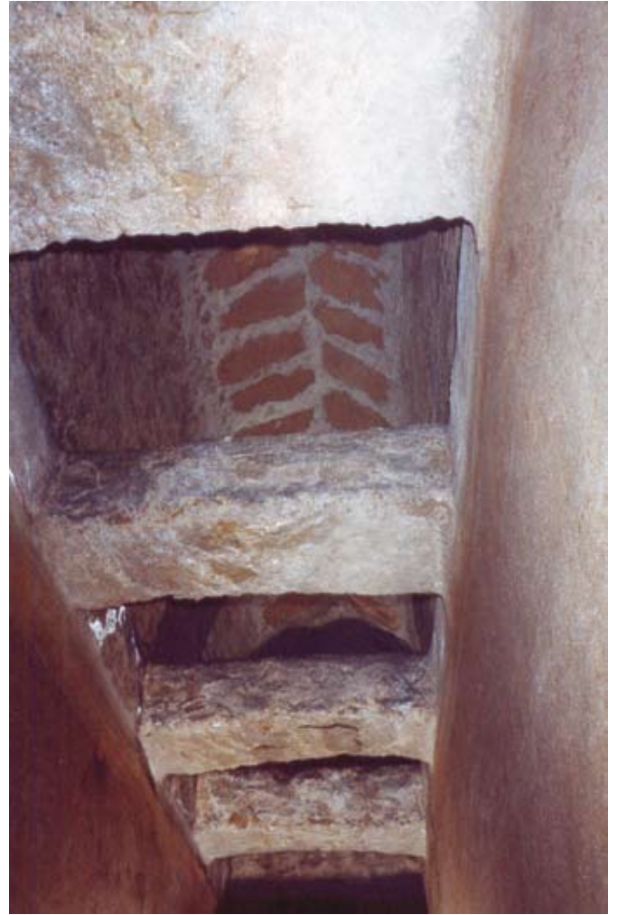
Fig. 10 - Ambito A del rilievo topografico. Particolare della doppia sequenza di ponti in muratura rilevati nella cisterna n. 4 (foto R. Varriale).
