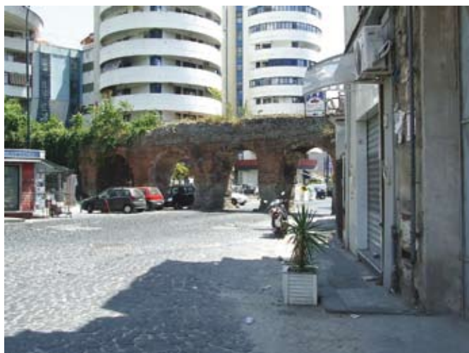
Fig. 2 - Sito archeologico dei Ponti Rossi a Napoli. Tratto dell'antico acquedotto romano del Serino (foto R. Varriale).
