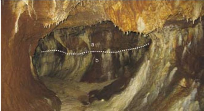
Fig. 2 - Alternanze di livelli di ghiaie di conoide (a) e paleosuoli (b) all'interno dell'acquedotto. I punti di concrezionamento evidenziano le venute d'acqua dai livelli ghiaiosi (foto S. Del Prete).
