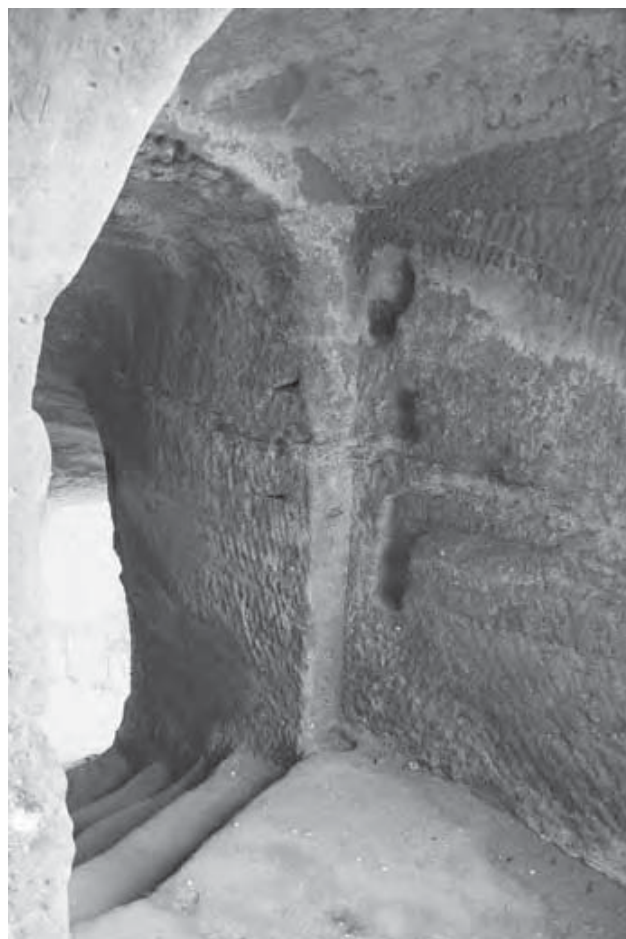
Fig. 8 - Drachenfels: closing system hewn into the rock. Fig. 8 - Drachenfels: sistema di chiusura scavato nella roccia.
