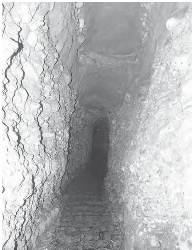
Fig. 18 - Fonte Torinese, particolare successione litologica del cunicolo principale direzione E, sabbia e conglomerato (foto A. De Ascentiis).
