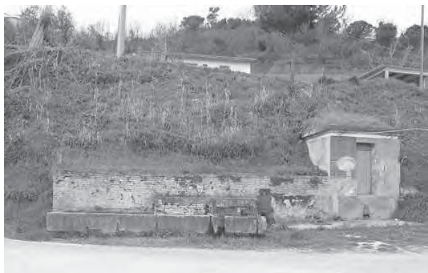
Fig. 25 - Fonte S. Ilario, facciata fontana come si presenta attualmente (foto A. De Ascentiis).
