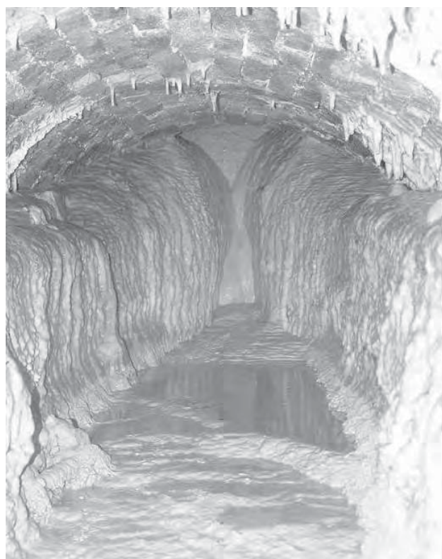
Fig. 35 - Fonte Brecciola, ostruzione calcarea cunicolo principale (foto A. De Ascentiis).
