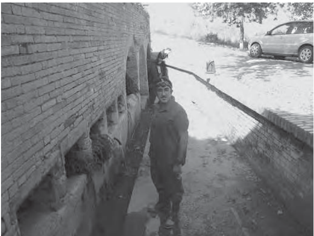
Fig. 22 - Fonte Fontecchio, esterno fontana, visibili parte superiore in laterizio e parte sottostante in blocchi di pietra serena (foto A. De Ascentiis). Fig. 22 - Fonte Fontecchio, outdoor fountain, visible at the top brickworks and underside blocks of stone (photo A. De Ascentiis).
