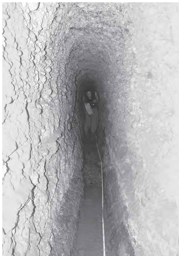
Fig. 23 - Fonte Fontecchio, cunicolo principale scavato nella formazione conglomeratica (foto A. De Ascentiis).
