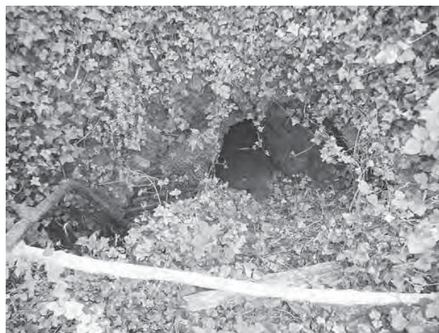
Fig.12 - Fonte Argentina, ingresso cunicolo attraverso l'arco parzialmente crollato (foto A. De Ascentiis).
