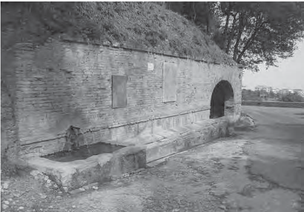
Fig. 29 - Fonte Pila, facciata fontana dove sono visibili le modifiche apportate nel corso degli anni - tracce di più cannelli lungo il lavatoio, ingresso del cunicolo obliterato e lapide con poesia del Prof. L. Illuminati (foto A. De Ascentiis). Fig. 29 - Fonte Pila, facade fountain where you can see the changes over the years - traces of more torches along the wash, entrance to the tunnel obliterated and plaque with poetry of Prof. L. Illuminati (photo A. De Ascentiis).
