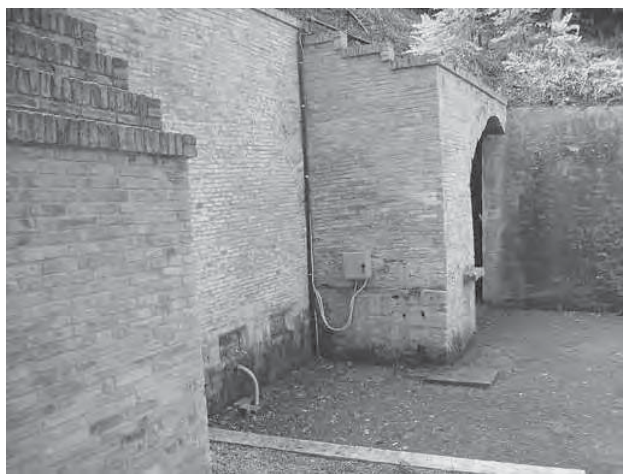
Fig. 37 - Fonte Strega, esterno fontana dove sono visibili le modifiche apportate di recente (foto A. De Ascentiis).
