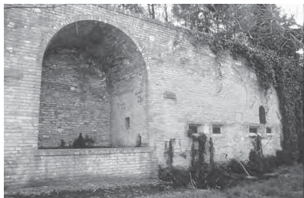
Fig. 32 - Fonte Brecciola, facciata fontana caratterizzata da una vasca di accumulo esterna sotto l'arco a tutto sesto e visibili quattro finestrelle di ispezione alle vasche coperte (foto A. De Ascentiis).
