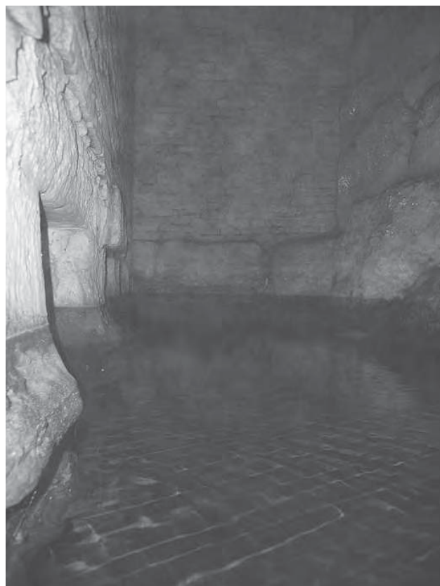
Fig. 39 - Fonte Strega, interno vasca in blocchetti di calcare (foto A. De Ascentiis).
