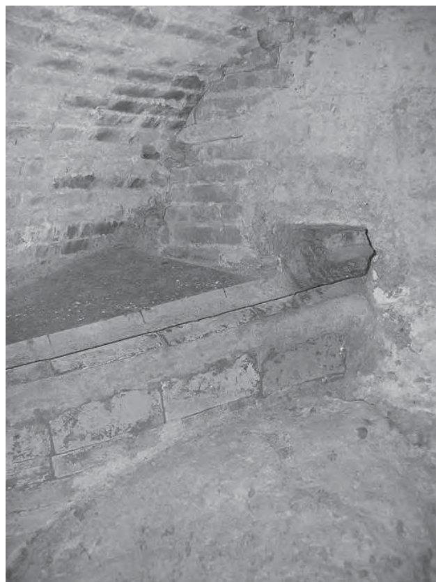
Fig. 30 - Fonte Pila, particolare lavatoio interno (foto A. De Ascentiis).
