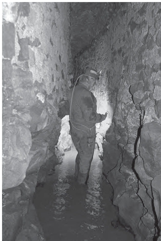
Fig. 5 - Cunicolo emissario di Laghetto (foto C. Germani). Fig. 5 - The Laghetto outlet. A view of the tunnel (photo C. Germani).
