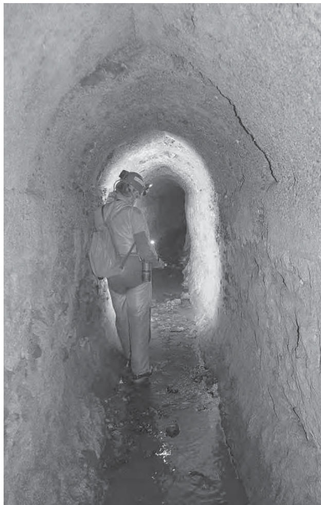
Fig. 8 - Cunicolo emissario di Pantano Secco (foto C. Germani).
