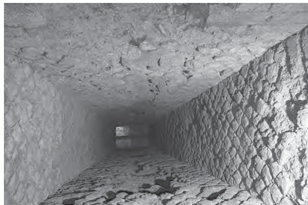
Fig. 10 - Cunicolo emissario di Pantano Secco. Pozzo n.2 rivestito in opera reticolata (foto C. Germani).
