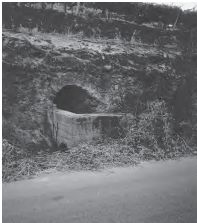
Fig. 11 - Ingresso dell'emissario di Pantano Secco nel 1991 (a sin.) e nel 2009 (a destra). Sono evidenti le tracce dell'incendio che ne ha "rivelato" la presenza e la paratia ora demolita e sostituita da tubazioni interrato (foto C. Germani, 2009, e V. Caloi, 1991).
