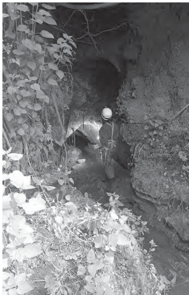
Fig. 23 - Emissario di Giulianello. Il fondo di uno degli sprofondamenti che, con ogni probabilità, corrispondono ad altrettanti pozzi collassati. Il cunicolo residuo è impercorribile (foto C. Germani).
