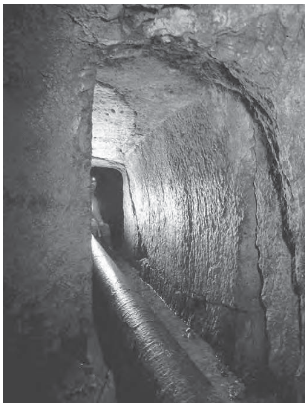
Fig. 16 - I segni circolari lasciati sulle pareti di durissima roccia lavica da utensili ben diversi dai normali picconi (foto C. Germani).
