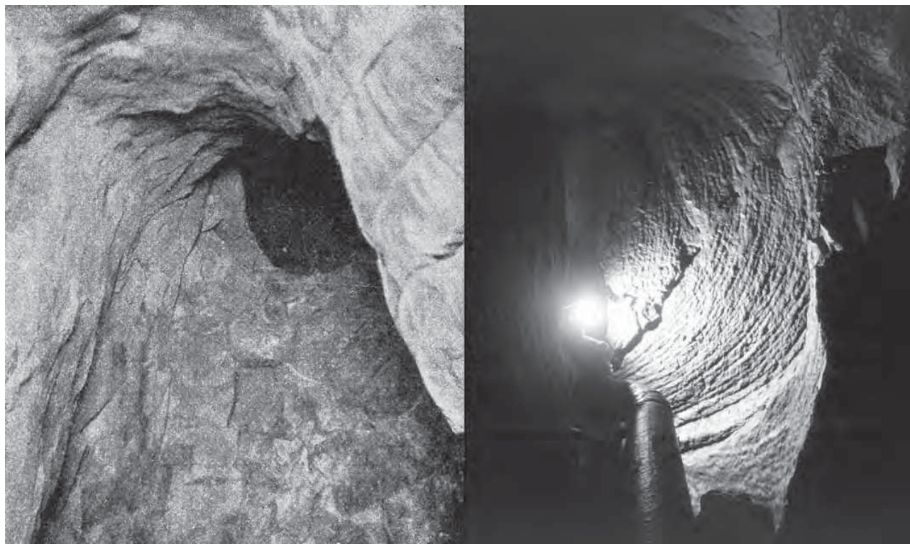
Fig. 17 - L'incontro tra i due fronti di scavo prima e dopo i lavori del 1928-30 (foto: a sinistra da UCELLI, 1940 e, a destra, C. Germani).
