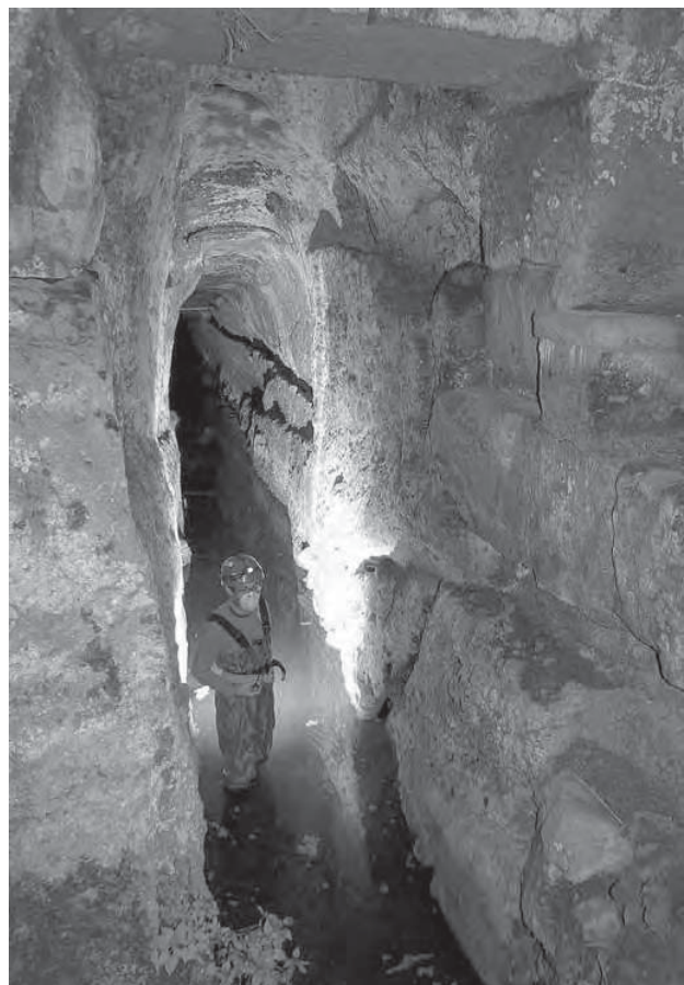
Fig. 9 - La difficile situazione all'interno dell'emissario dalla parte dell'incile, con il fondo coperto di fango vischioso e acqua, e con un forte odore di decomposizione vegetale (novembre 2009); (foto C. Germani)
