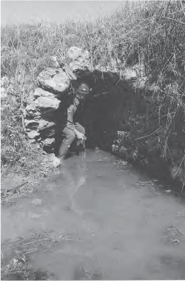
Fig. 22 - La terminazione del canale realizzata in blocchi di pietra a secco.
