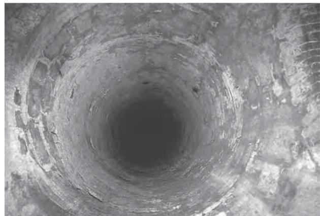
Fig. 8 - Uno dei dieci pozzi di aereazione aperti sulla volta della galleria del Granduca.
