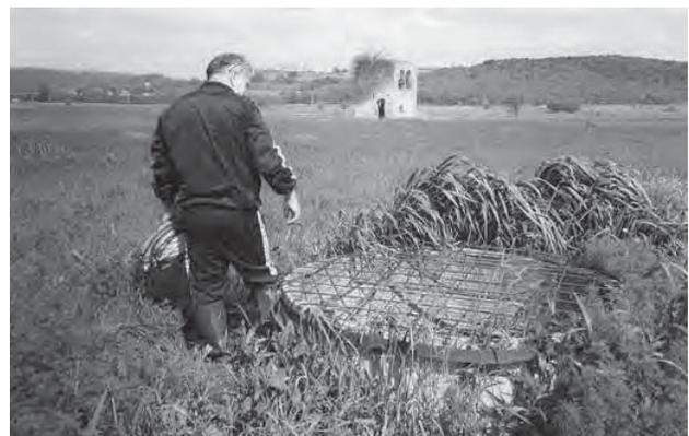
Fig. 19 - L'imbocco di uno dei pozzi di aereazione della galleria di Badia a Isola restaurato e protetto da griglia metallica.
