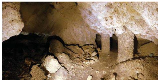
Fig. 3 - Grotta di Zumpin (Osoppo). Colonne artificiali a sostegno della volta (foto D. Bertossi).
