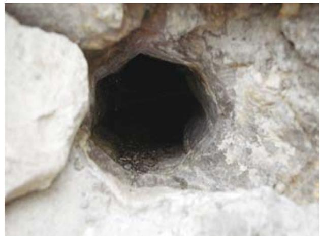
Fig. 6 - Foro trasversale a sette lati.
