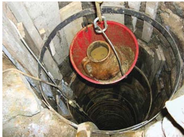
Fig. 6 - Recupero di uno dei reperti ceramici perfettamente integro (foto R. Bixio).
