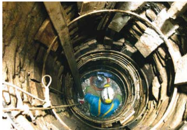
Fig. 5 - Operazioni di scavo a metà pozzo con la pompa a immersione in funzione. Si notano le dimensioni molto ridotte del vano (foto R. Bixio).
