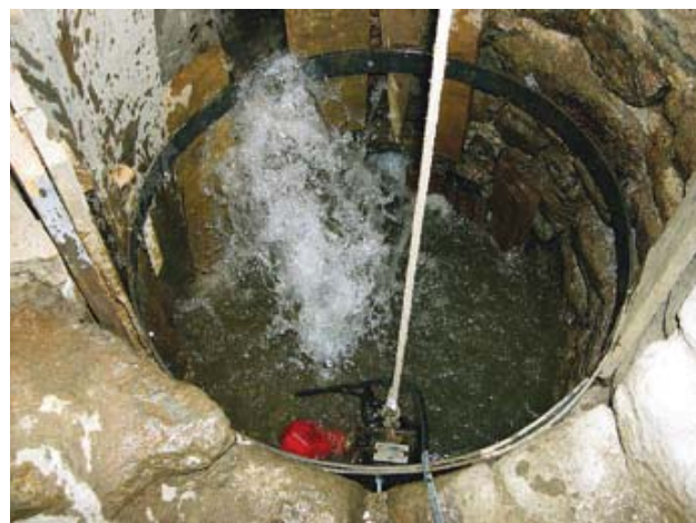
Fig. 4 - La pompa a immersione in azione all'interno del pozzo di età romana (foto R. Bixio).
