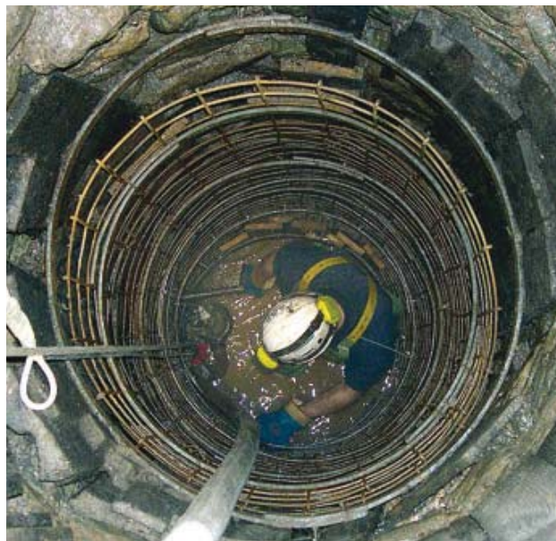
Fig. 8 - Ogni modulo, una volta posizionato, veniva bloccato con una o più centine metalliche (foto R. Bixio).
