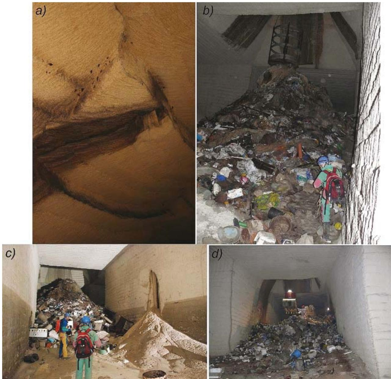
Fig. 6 - Situazioni di degrado in cave sotterranee: a) tracce di scarichi fognari illegali a Gallipoli; b, c, d) cumuli di spazzatura a Cutrofiano (foto b,c: G. Donno).
