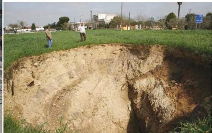
Fig. 3 - Recenti sprofondamenti connessi a cave sotterranee ad Altamura (foto: CARS) e in agro di Cutrofiano.
