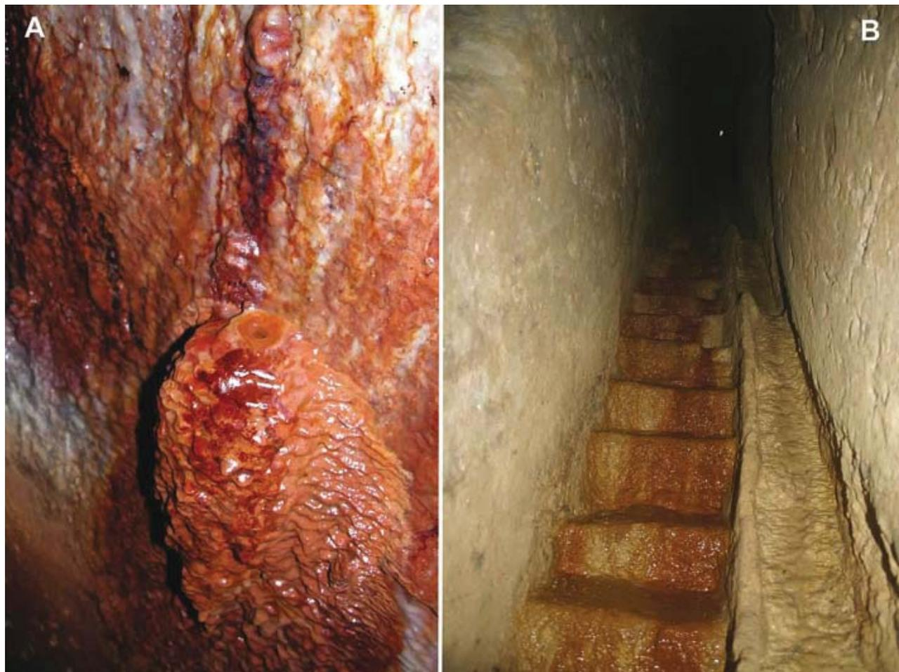
Fig. 8 - A: Una antistalattite, formata da ossidi idrossidi di ferro; B: La Scala Romana ricoperta da uno strato di concrezioni carbonatiche.
