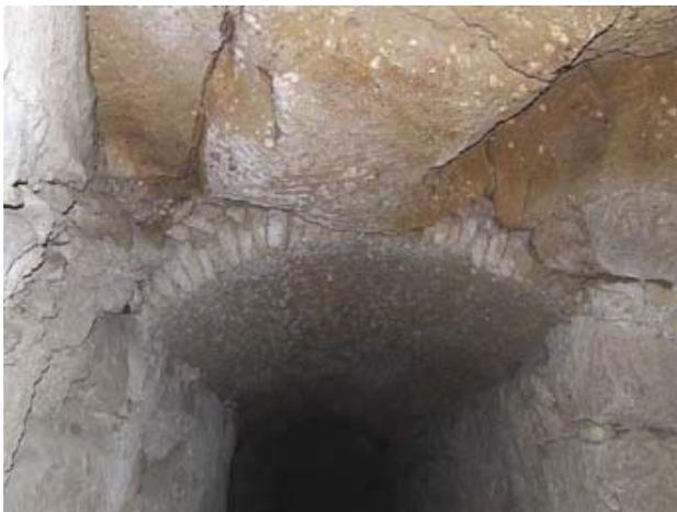
Fig. 14 - Sezione del rivestimento della volta della galleria in muratura di tufo giallo (foto R. Varriale).
