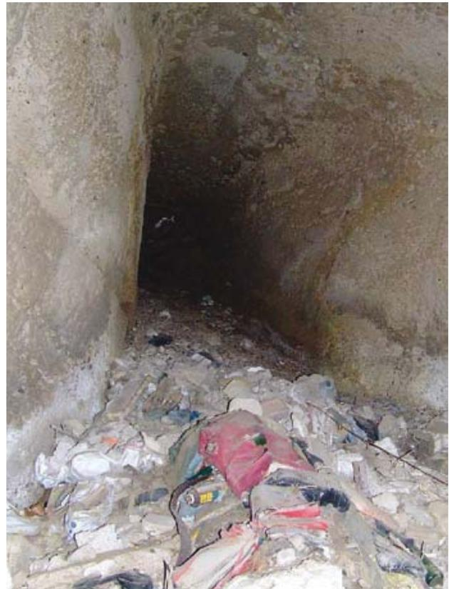
Fig. 12 - Seconda apertura laterale della galleria, parzialmente ostruita da detriti e rifiuti (foto R. Varriale).
