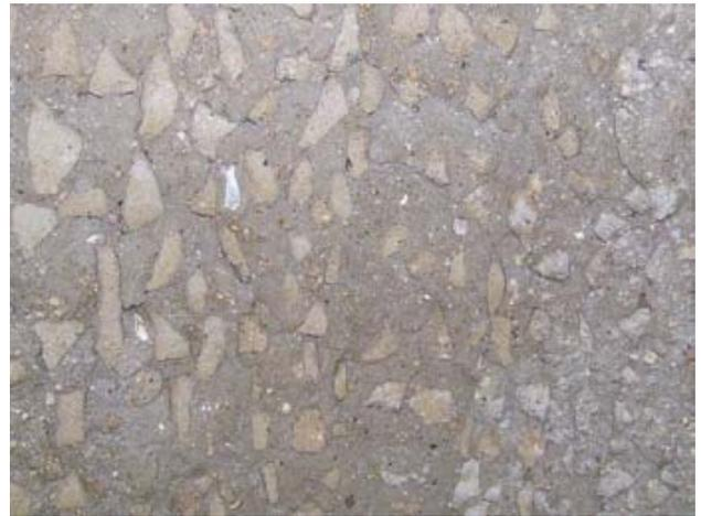
Fig. 15 - Dettaglio del rivestimento in muratura di tufo della volta della galleria (foto R. Varriale).
