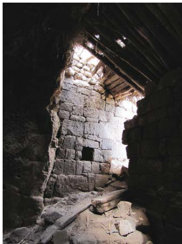
Fig. 2 - Harabeşehir. Molti degli ipogei artificiali di Ahlat conservano i resti di edifici costruiti e di coperture in legno che completano e chiudono il fronte esterno della cavità (foto A. De Pascale).
