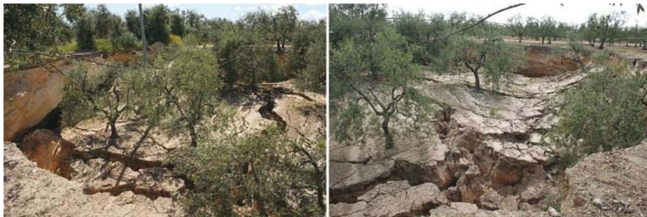
Fig. 1 - Vedute parziali del sinkhole.
