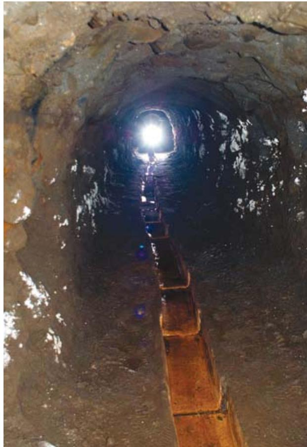
Fig. 3 - Tratto iniziale del cunicolo n. 1, probabilmente rimaneggiato nell'800 e dotato di canaletta centrale in laterizio (foto C. Germani).
