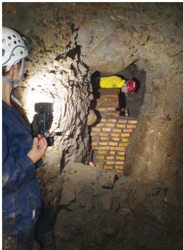
Fig. 8 - Cunicolo n. 2. La galleria trasversale non rivestita e parzialmente crollata con, in fondo, il termine del tratto rivestito a mattoni di figura 7 (foto C. Germani).
