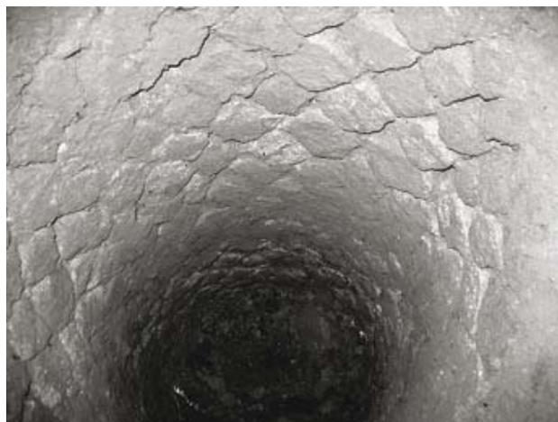
Fig. 14 - Cunicolo n. 4. Pozzetto rivestito in *opus reticulatum* (foto S. Galeazzi).
