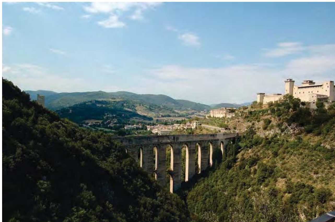
Fig. 25 - Panorama dell'acquedotto di Spoleto. Il Ponte delle Torri. Fig. 25 - Spoleto. Landscape with the aqueduct.
