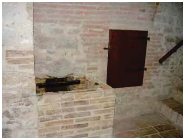
Fig. 8 - Convento delle Milizie. Il pozzo del refettorio.
