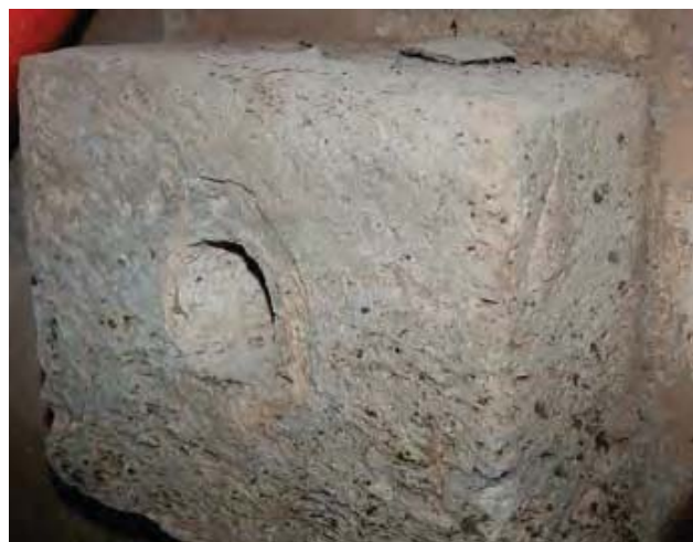
Fig. 6 - Todi, S. Fortunato. Cisterna del Chiostro, sfioro in travertino.
