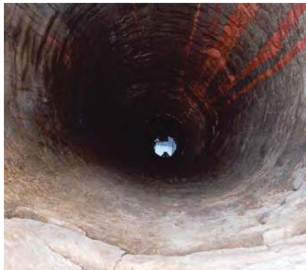
Fig. 9 - Todi, Monastero delle Lucrezie. Interno del pozzo drenante.
