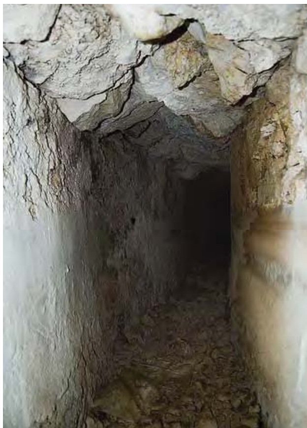
Fig. 24 - Spoleto-lo “specus” a monte della vasca di raccolta. Fig. 24 - Spoleto – the “specus” upstream the collection pond.
