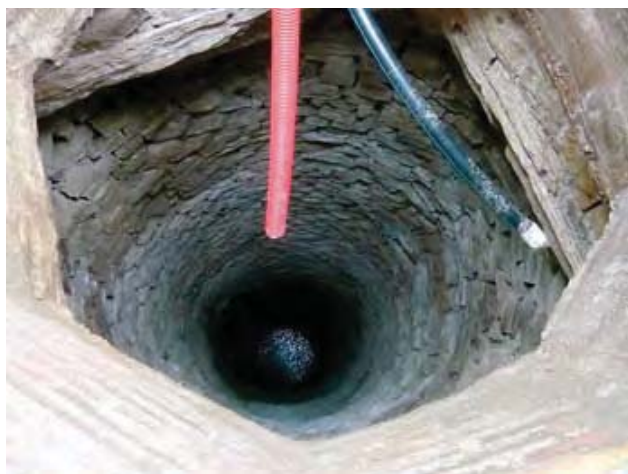
Fig. 15 - Convento di Montesanto. Il pozzo di falda. Fig. 15 - Montesanto Convent. The well groundwater.
