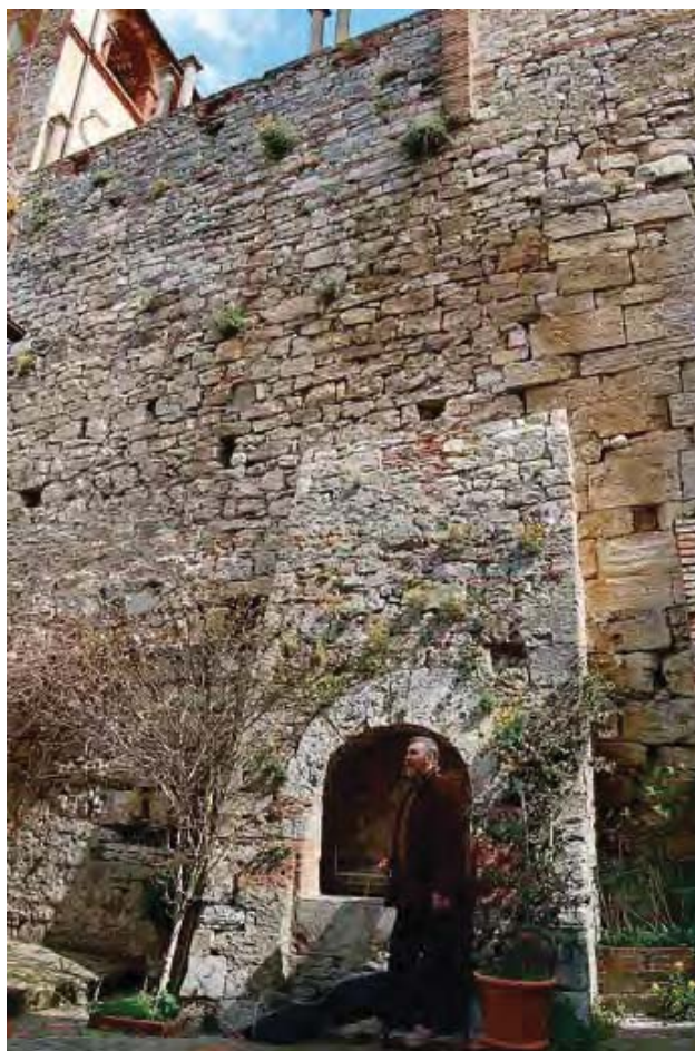
Fig. 10 - Todi, Monastero delle Lucrezie. Ispezione pozzo inglobato nel contrafforte.
