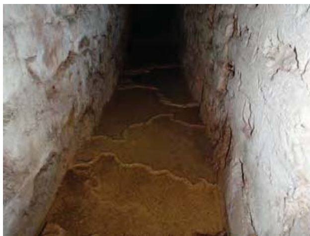
Fig. 23 - Assisi, Rocchicciola. Concrezionamenti a vaschette nel condotto proveniente da Panzo.
