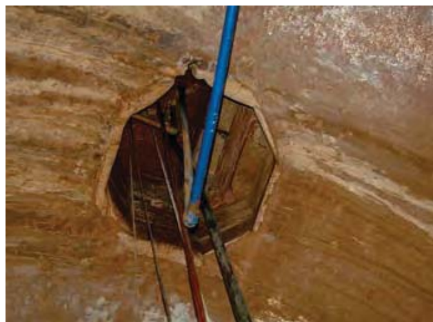
Fig. 7 - Todi, S. Fortunato. Cisterna del Chiostro. Il puteale visto da sotto.
