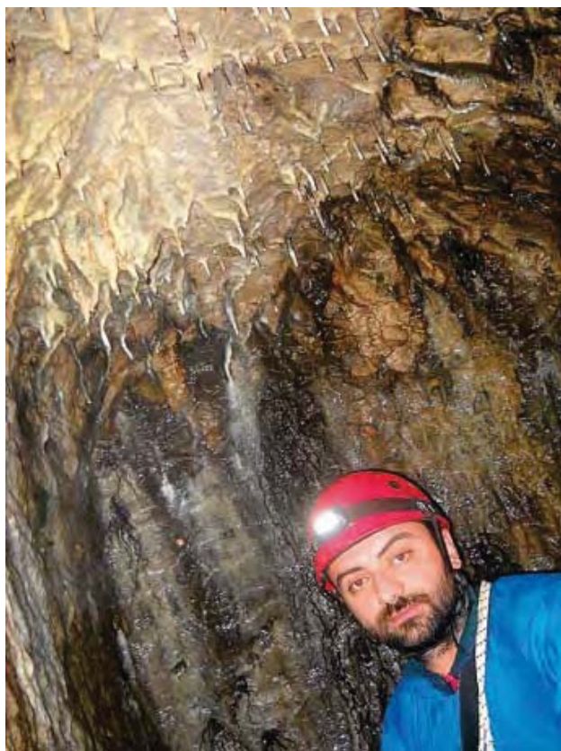
Fig. 14 - Condotta di Via dei Morti (foto Magnoni). Fig. 14 – Water pipe in Via dei Morti (photo Magnoni).
