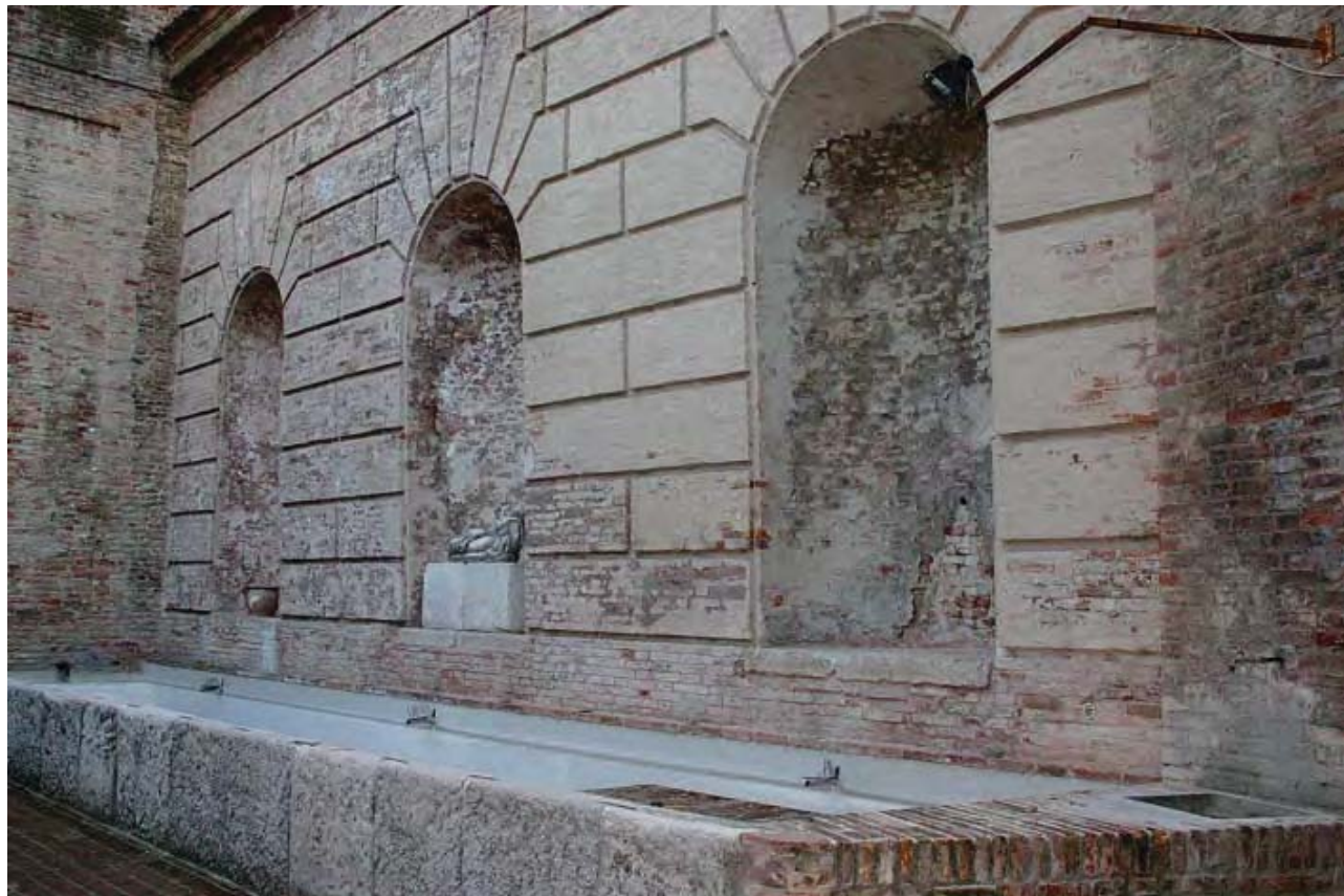
Fig. 8 - Condotta della Fonte del Leone (foto Magnoni). Fig. 8 - Fonte del Leone water pipe (photo Magnoni).
