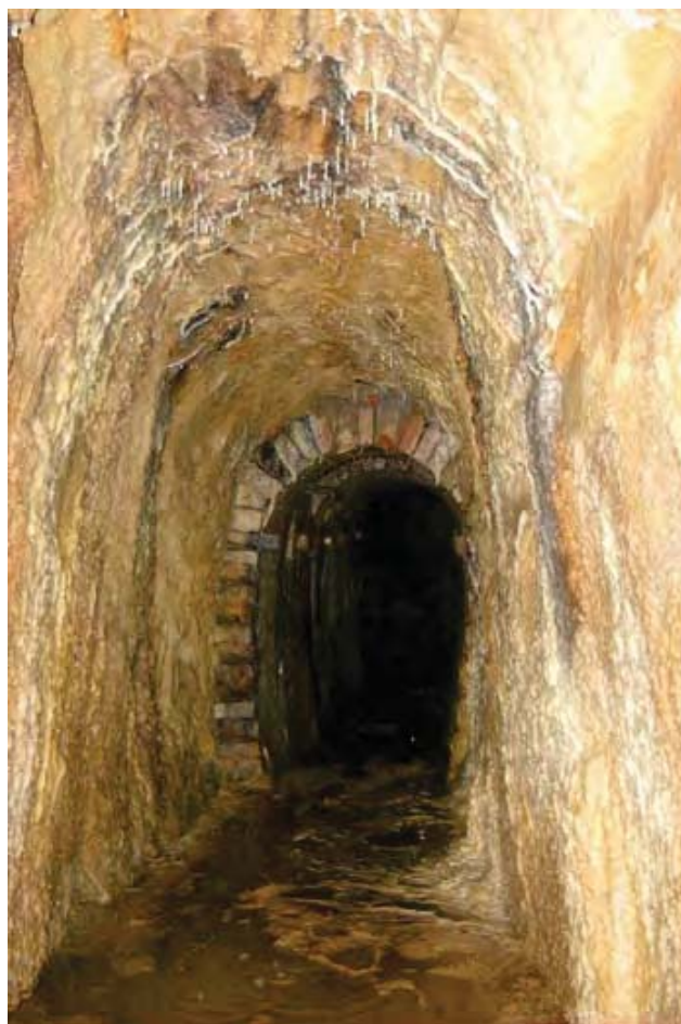
Fig. 13 - Condotta di Via dei Morti (foto Magnoni). Fig. 13 – Water pipe in Via dei Morti (photo Magnoni).
