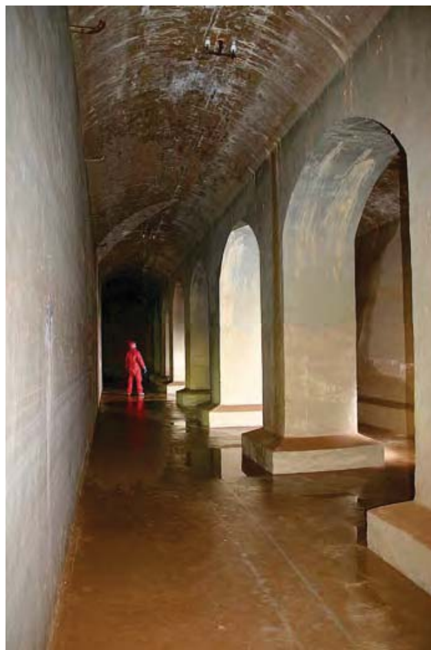
Fig. 16 - Cisterne del Monte (foto Magnoni). Fig. 16 - Monte water tanks (photo Magnoni).
