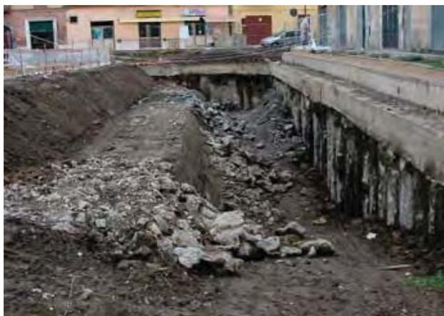
Fig. 8 - Scavo per l'ampliamento della cavità e palificata di contenimento.
