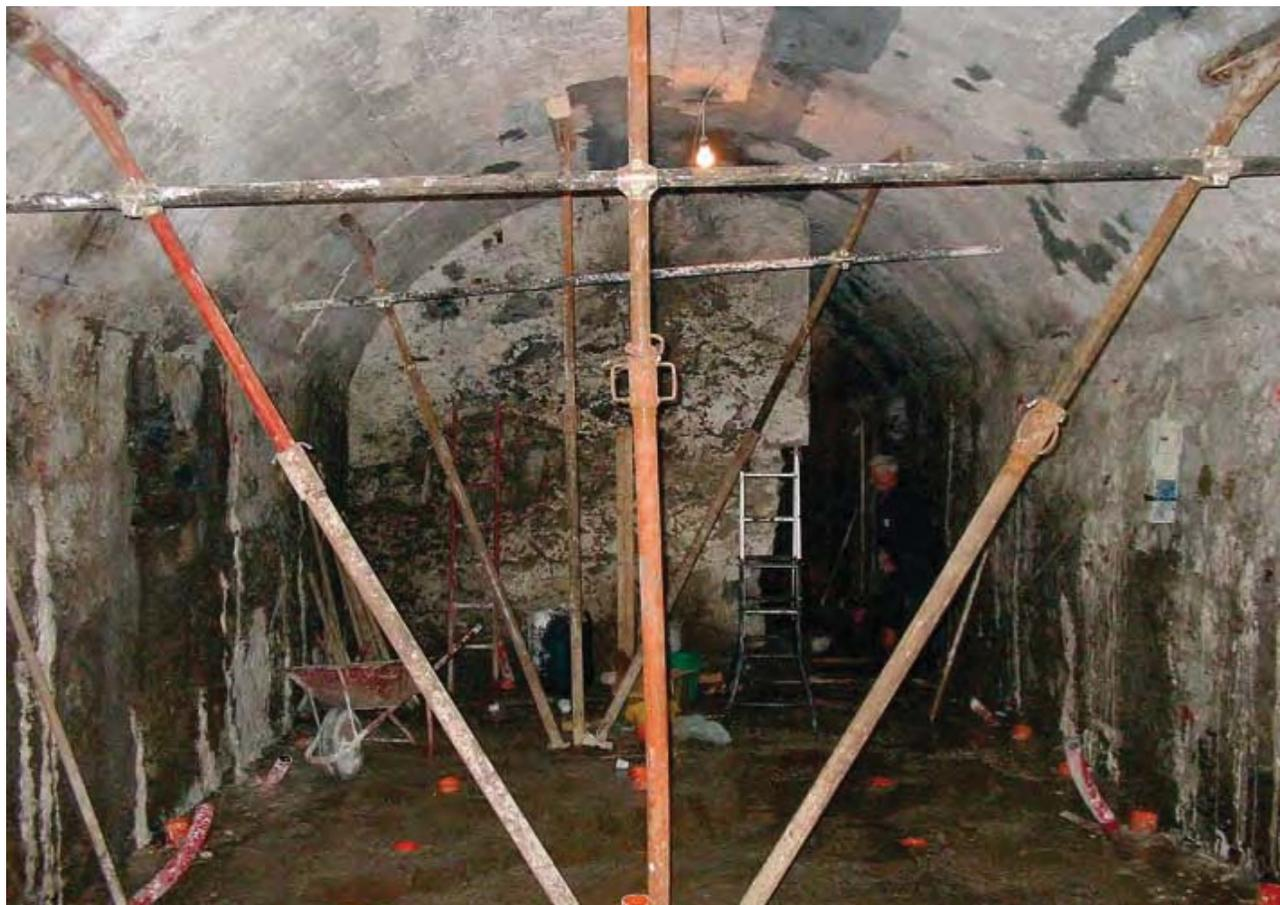
Fig. 7 - Fase di messa in sicurezza mediante puntellatura della volta.
