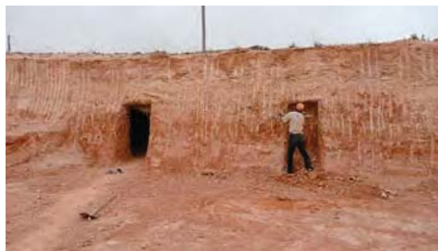
Fig. 9 - Fase di scavo dell'atrio di una nuova abitazione (foto F. dell'Aquila).
