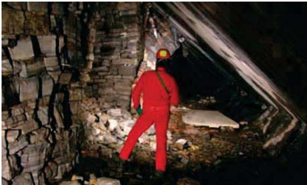
Fig. 8 - Galleria scavata lungo strato (foto A. Ferrario).
