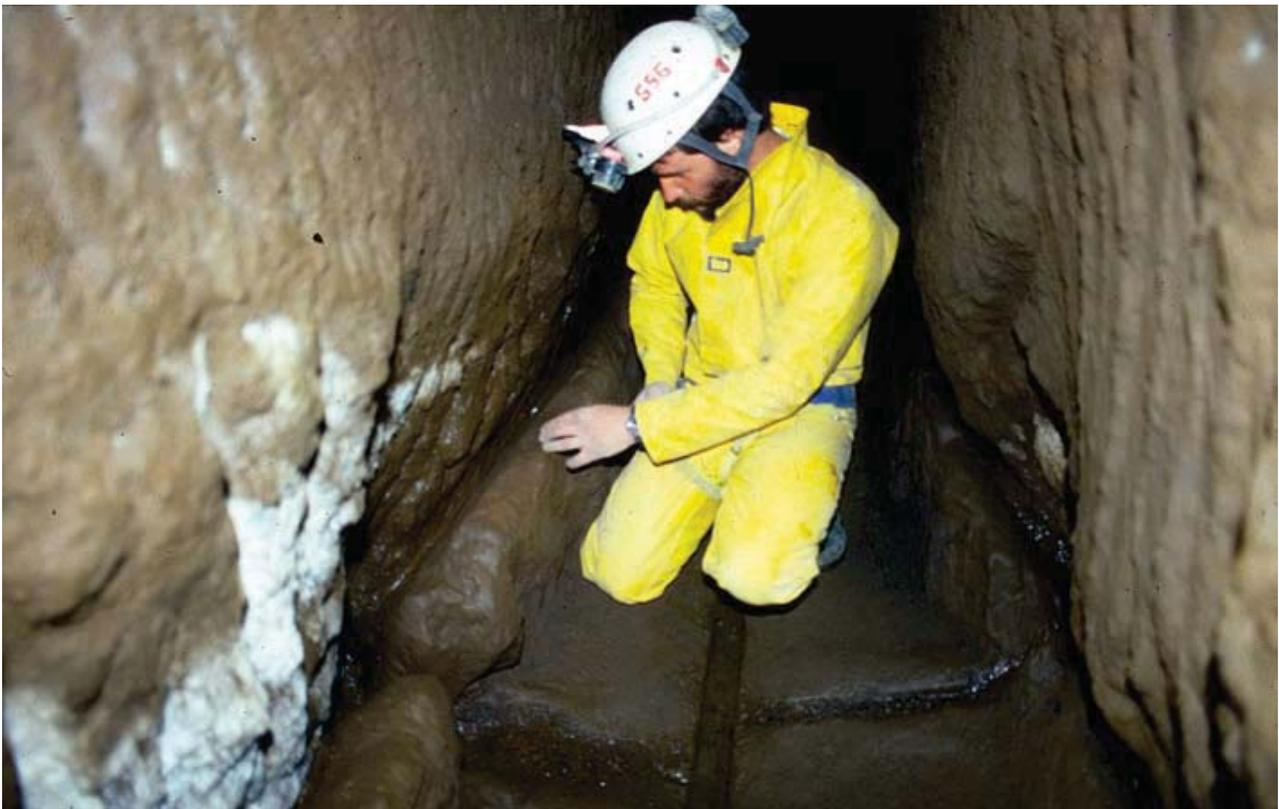
Fig. 2 - Cunicolo della Cisterna arcaica. Canalette di drenaggio (foto R. Testa).
