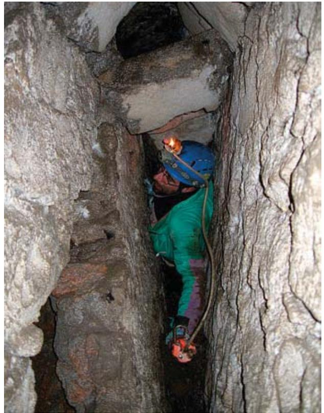
Fig. 10 - Settore terminale del Ramo Nord. Deformazione e rottura del rivestimento laterale in muratura cui ha fatto seguito il collasso della volta a cappuccina (foto S. Del Prete).
