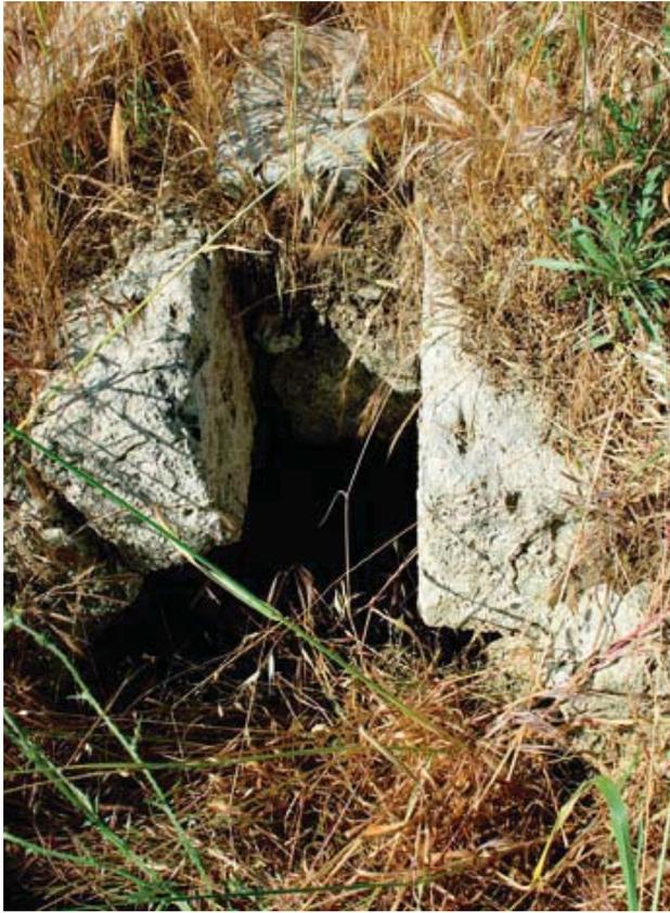
Fig. 7 - Tratto di volta fuori terra crollato dell'acquedotto di Pozzo Pateo (foto V. Tragni).
