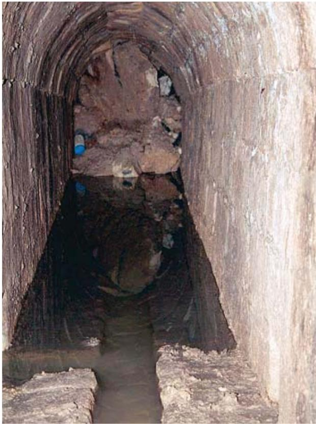
Fig. 10 - Vista della volta e della canaletta dell'acquedotto La Signora (foto M. Parisi).
