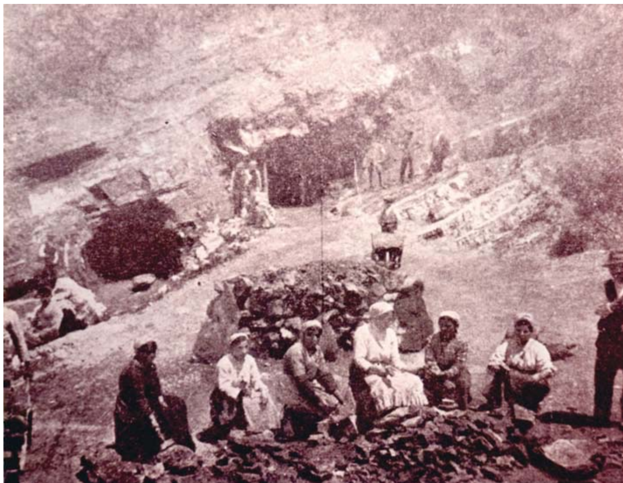
Fig. 1 - Ingresso miniera di Ittiolo, località Patanaro (archivio foto Cianciulli C.).
