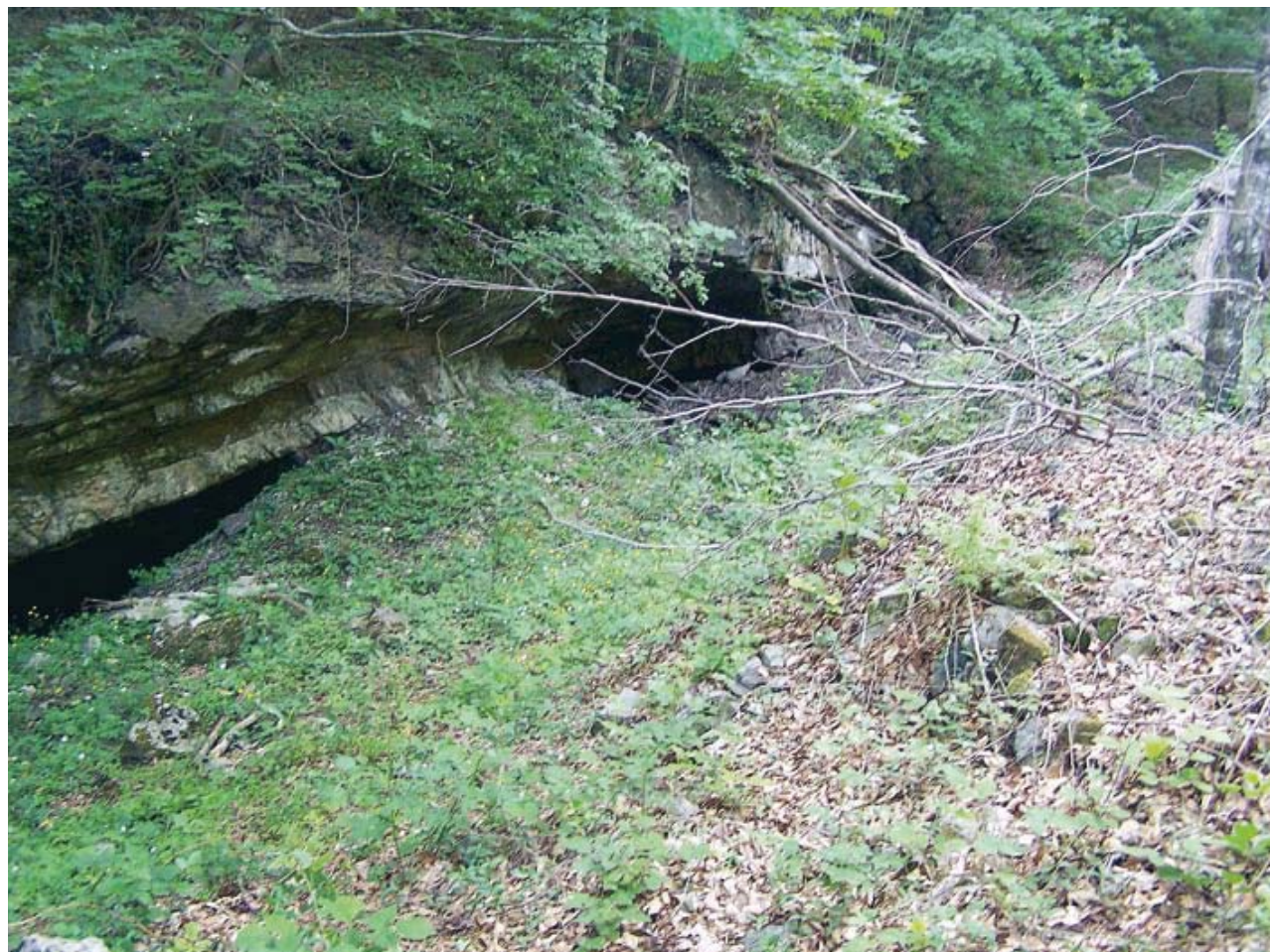
Fig. 7 - Alcuni ingressi delle miniere in loc. Patanaro (foto S. Mancino).
