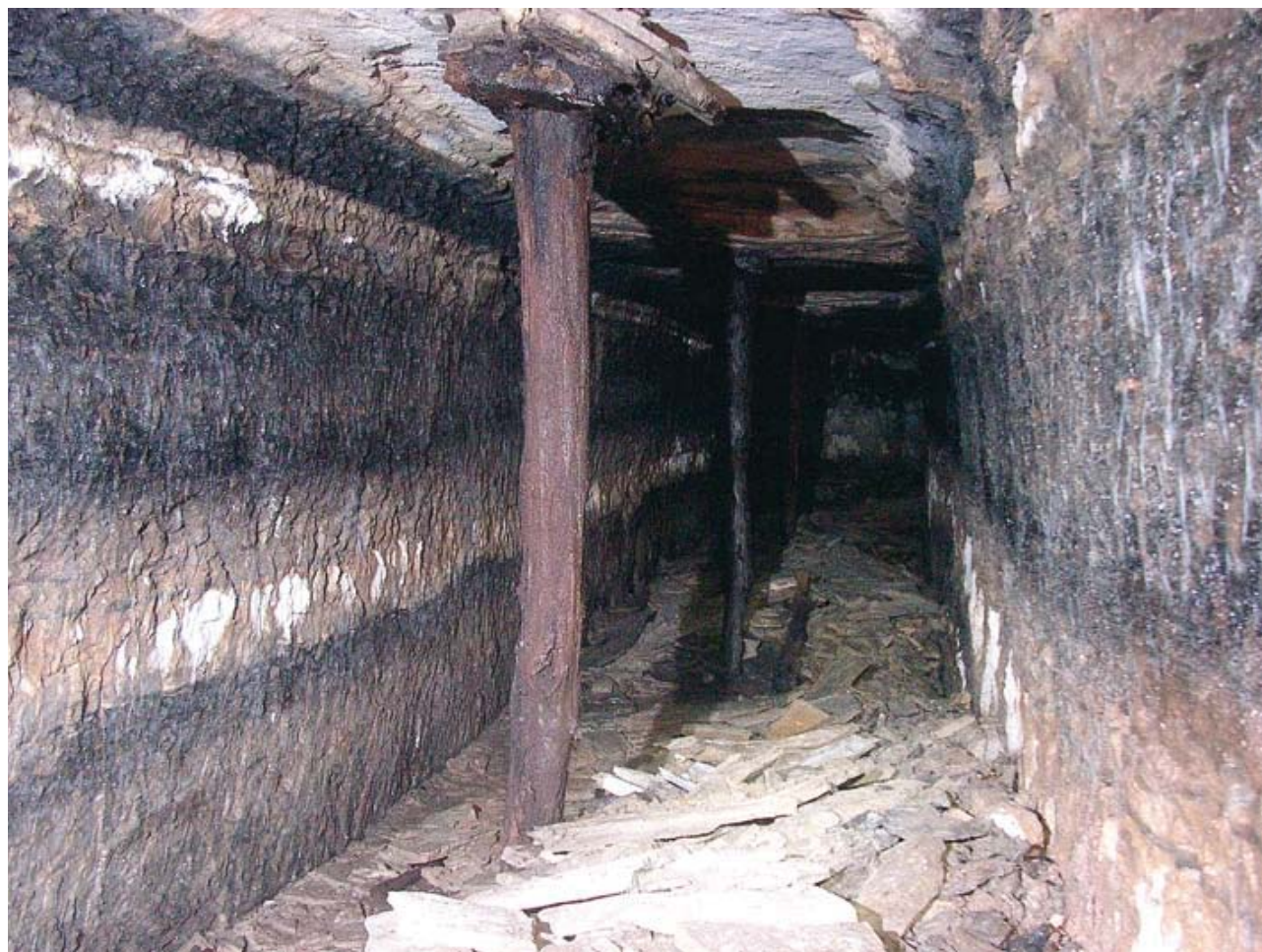
Fig. 5 - Alcuni cunicoli sono ancora armati con puntelli verticali in legno d'abete. Fig. 5 - Some tunnels are still reinforced with vertical pinewood props.
