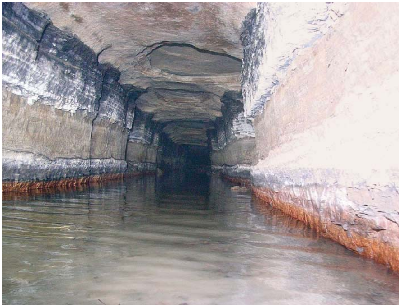
Fig. 2 - Alcune gallerie risultano allagate. Il livello dell'acqua può variare bruscamente da 0,2 m a 1,5 m.
