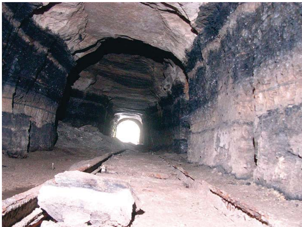
Fig. 1 - In alcune gallerie sono tuttora presenti i binari che consentivano il transito dei carrelli per il trasporto della lignite dall'interno all'esterno della miniera.
