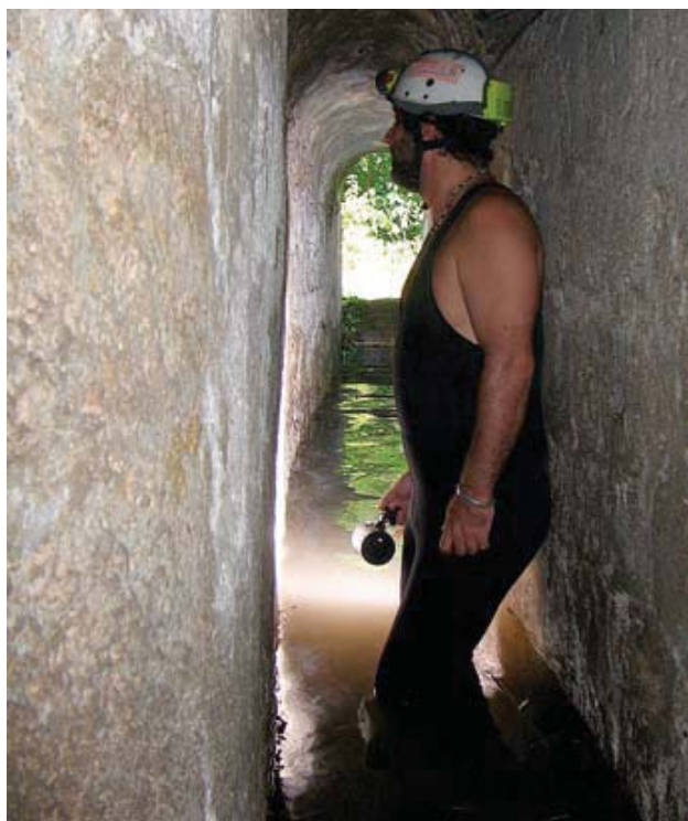
Fig. 4 - Tratto iniziale della Galleria Felice, completamente armata in muratura di pietrame saldata con malta; la volta, a botte, è sostenuta da un arco continuo. La soglia alta crea, grazie alla pendenza della galleria, un serbatoio di accumulo dell'acqua di profondità massima di circa 1m.
