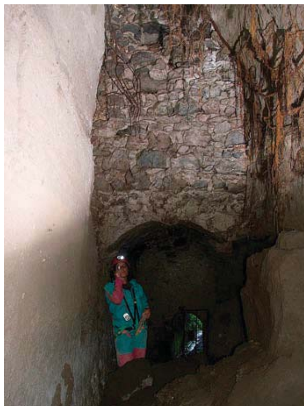
Fig. 9 - Tratto iniziale della Galleria Olivella 1. Si notino il muro di sostegno in muratura di pietrame, con basamento ad arco, gli apparati radicali degli alberi soprastanti che invadono la galleria e l'accumulo di materiale franato sul fondo della galleria. Fig. 9 - Initial segment of Olivella 1 gallery. It is evident the supporting masonry wall, with arch-shaped basement, the tree roots on the ceiling and the accumulation on the floor of material detached from the ceiling.
