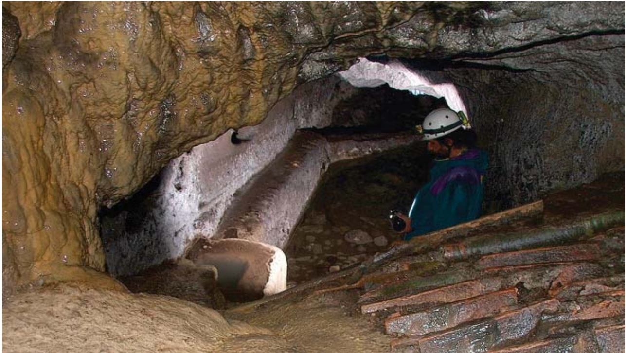
Fig. 14 - Opera di convogliamento delle acque di stillicidio della Galleria Olivella 2, realizzata con gruppo di tegole rovesce in cotto e canale di adduzione sulla parete sinistra. Notare in fondo la vaschetta concrezionata da dove le acque traboccano nella vasca principale.
