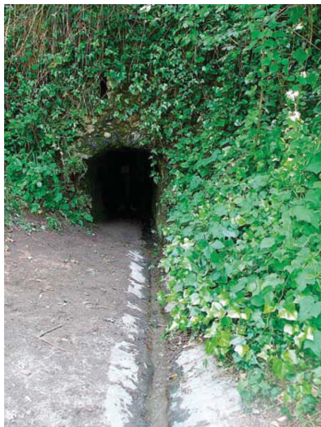
Fig. 8 - Imboccatura della Galleria Olivella 1, con canale di eduazione delle acque in basole di lava giustapposte con sezione a "V". Fig. 8 - Entrance of the Olivella 1 gallery, with output V-section channel in lava masonry.
