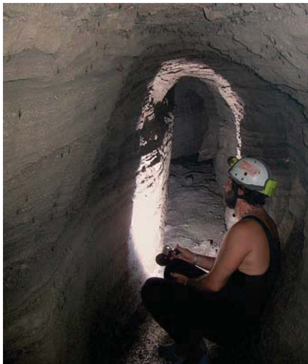
Fig. 5 - Tratto interno della Galleria Felice, privo di qualsiasi opera di sostegno.
