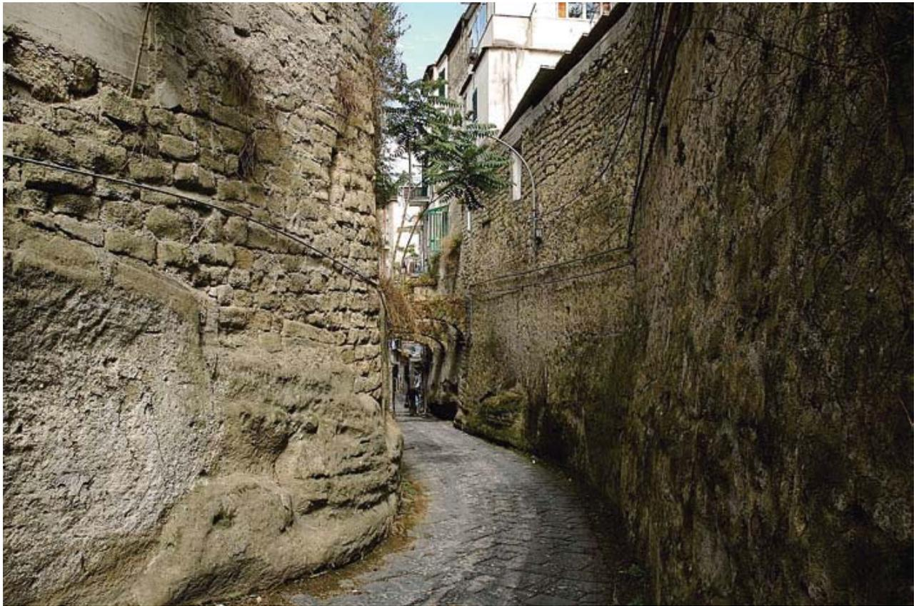
Fig. 1 - Napoli. Via del Serbatoio. Strada intagliata realizzata regolarizzando un alveo naturale.
