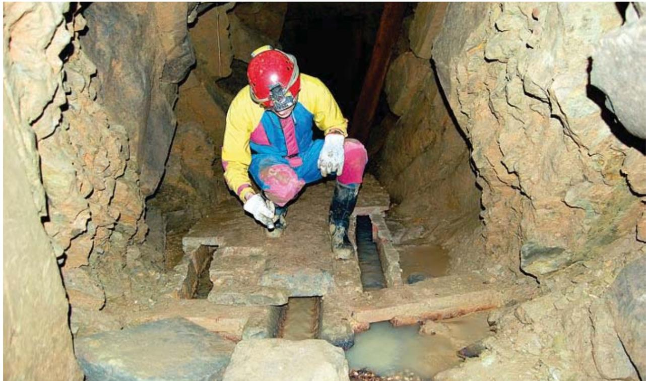
Fig. 7 - "Pavimento attrezzato". Al centro la canaletta realizzata con "docce", elementi componibili in arenaria - Punto n. 13 nella planimetria generale.
