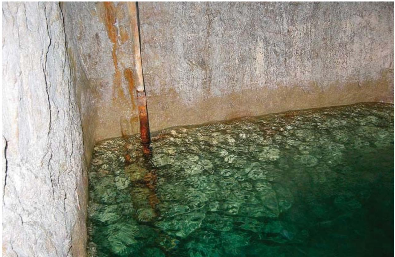
Fig. 6 - Cisterna di decantazione nel tratto iniziale della galleria di drenaggio (foto A. Marangella).
