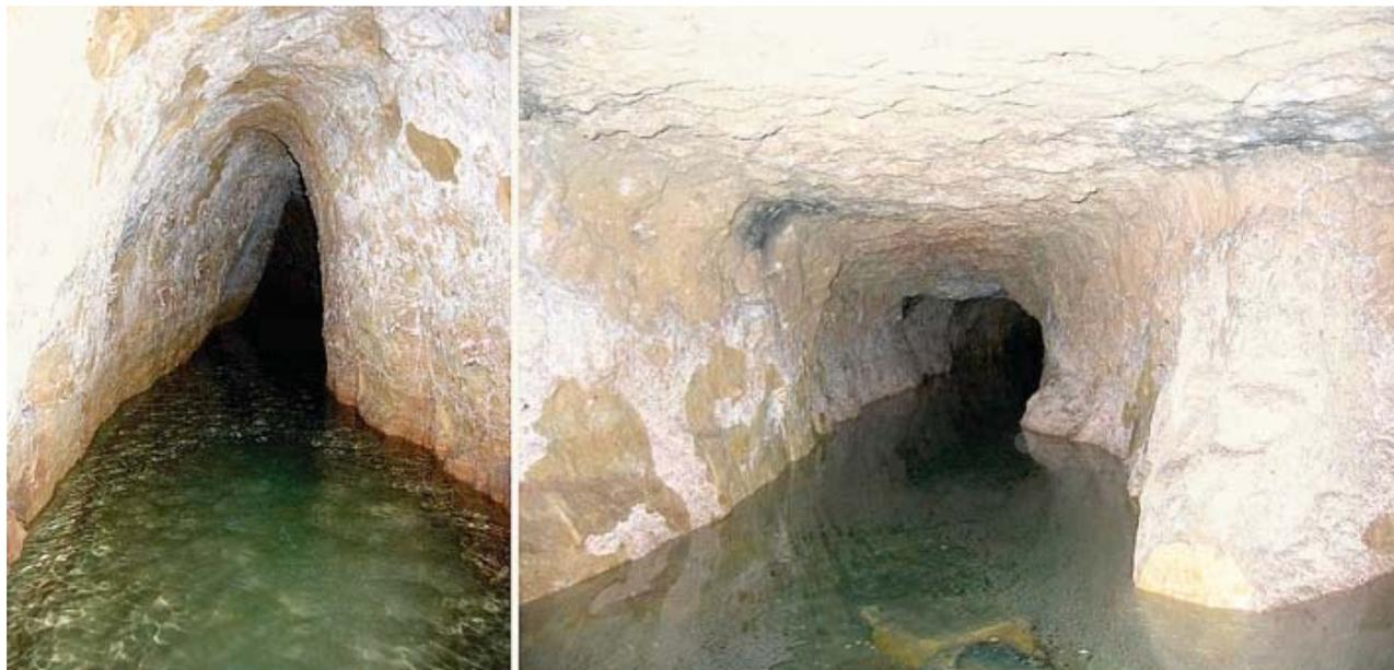
Fig. 10 - Esempio di galleria di drenaggio (foto A. Marangella).
