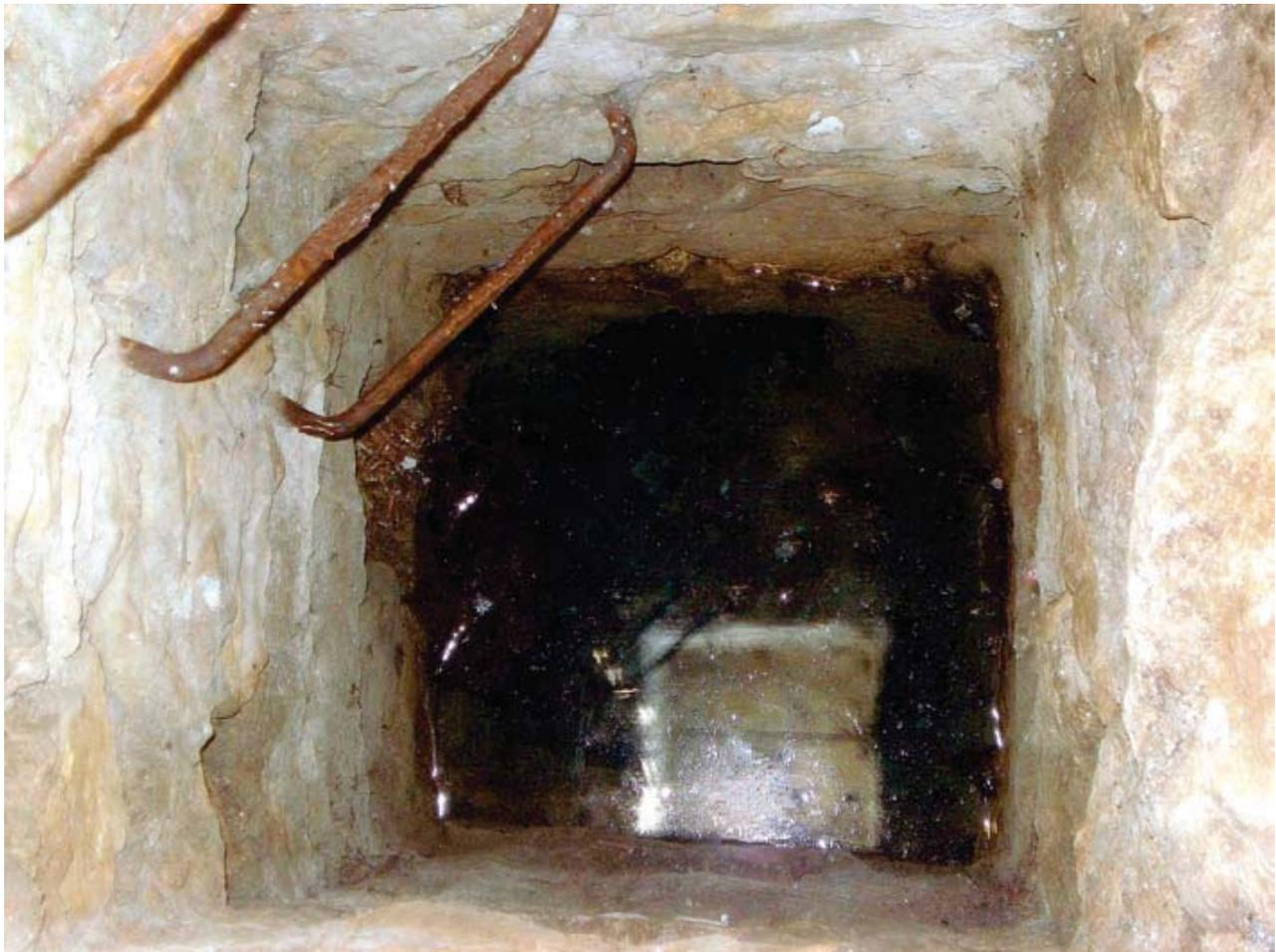
Fig. 11 - Interno del pozzetto di ispezione particella 216. Sotto il pelo dell'acqua si intravede il cunicolo proveniente dal pozzetto 202 (foto L. Casciotti).
