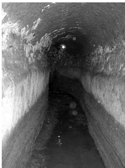
Fig. 14 - il cunicolo di diramazione verso i ninfei segnalati da Descemet (foto: C. Germani).
