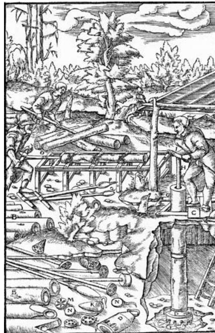
Fig. 8 - pag. 151. Pompa azionata a mano, sulla sinistra costruzione dei tubi ed, in basso particolari costruttivi.
