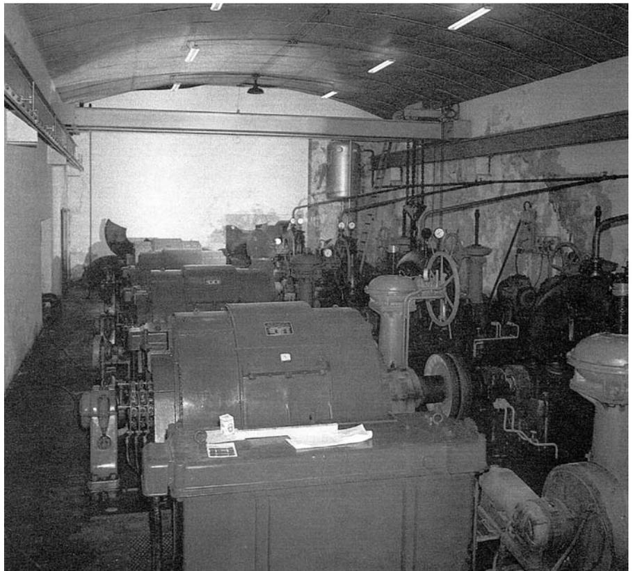
Fig. 13 - Impianto di pompe della miniera di Monteponi al livello -100.
