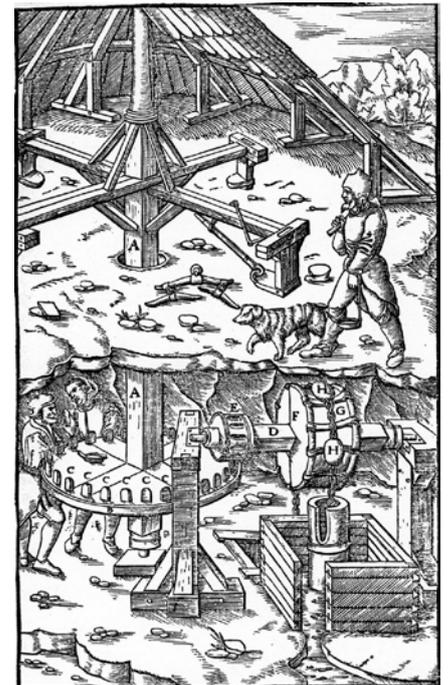
Fig. 9 - pag. 168. Pompa costituita da palle H disposte lungo una catena. La pompa è azionata da coppie di cavalli.
