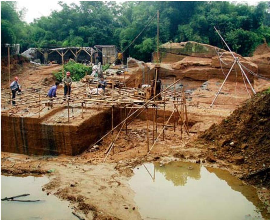
Fig. 11 - Settembre 2001: lavori di consolidamento della superficie delle arenarie in corrispondenza delle maggiori fratture riscontrate in grotta.
