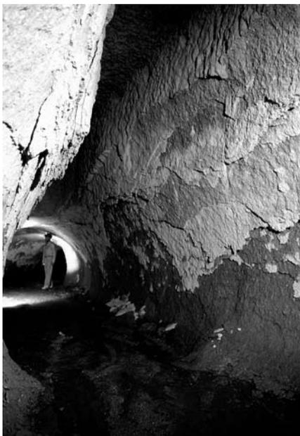
Fig. 9 - Valle di Meskendir (Cappadocia). L'azione di erosione millenaria in un cunicolo di drenaggio scavato dall'uomo ha comportato una profonda reincisione dell'opera idraulica la cui sezione originaria è in parte rimasta sospesa sulla volta della cavità (Foto G. Bologna). Nel caso specifico il rimodellamento della sezione è dovuto anche a processi di esfoliazione per gelivazione.
