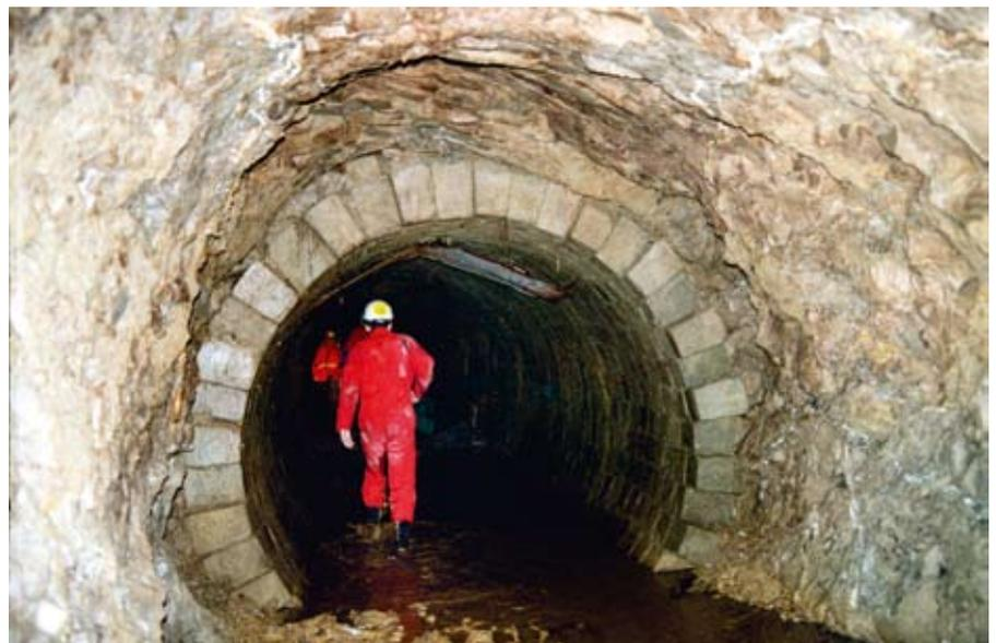
Fig. 4 - Miniere di cinabro della valle del Siele (Toscana). Passaggio litologico tra rocce litoidi dotate di buone caratteristiche di autosostegno (calcari marnosi in primo piano privi del rivestimento) e argilloscisti fortemente spingenti (sullo sfondo), che invece necessitano della realizzazione di rivestimenti delle pareti per mantenere accessibile la galleria mineraria (foto: S. Del Prete).
