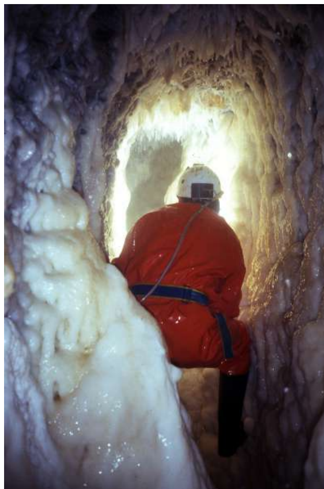
Fig. 6 – Tratto dell'acquedotto di Monteroduni particolarmente concrezionato (foto: M. Mancini).
