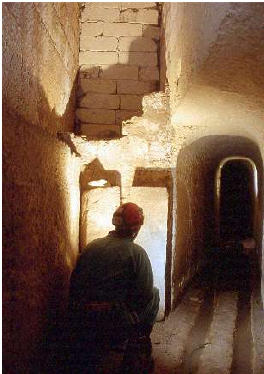
Figura 9 - Evidenti fasi di ampliamento del condotto con approfondimento della trincea e prosecuzione a valle in una galleria scavata nella roccia viva (Foto: G. Bologna).
