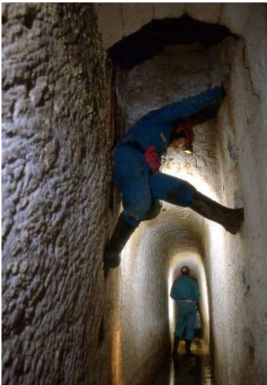
Figura 8 - Tratto di galleria scavato nella roccia viva, tra la Grotta della Fonte (punto G in Figura 1) e il Partitore. Da notare le pedarole per scendere dal pozzo di ispezione che collega alla superficie (Foto: M. Traverso).
