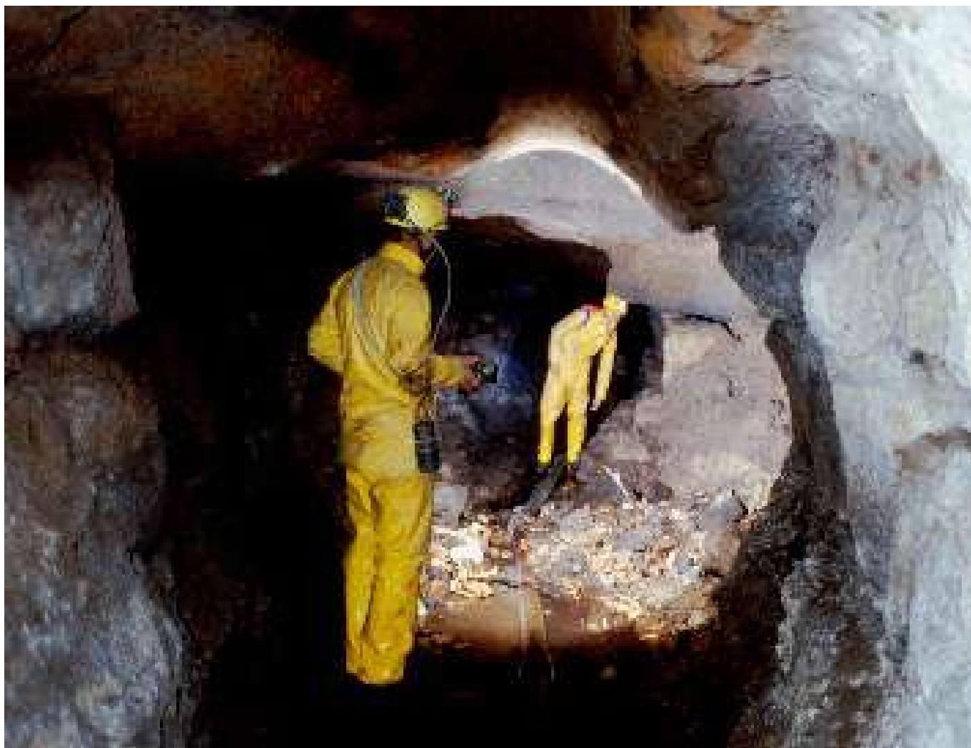
Figura 13 - Sezione franata dello speco in prossimità di presunta cavità naturale parzialmente allagata (Foto Gruppo Grotte Recanati).
