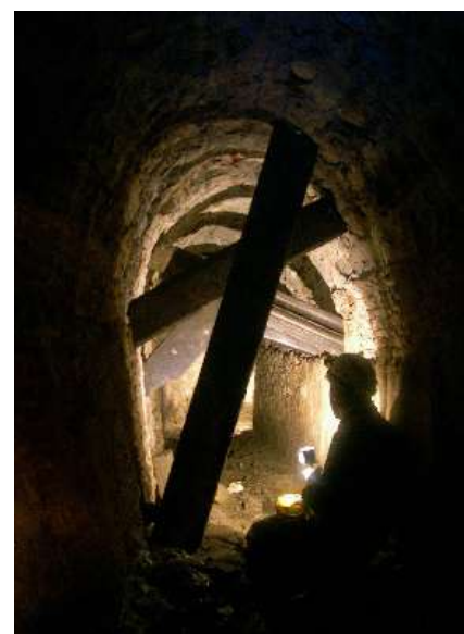
Figura 1 - Acquedotto Storico, Genova. Tratto della galleria di una presunta diramazione. La volta è stata puntellata in epoca sconosciuta con antichi stipiti di ardesia lavorata (Foto: G. Barranco).
