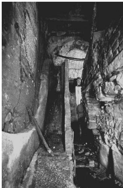
Figura 9 - Roggia dei Mulini, Genova. Gli scivoli dove erano alloggiate le ruote, oggi scomparse. (Foto: Mauro Traverso)
